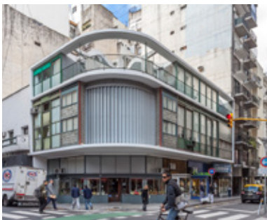
Figura 2.06. "Edifício de Ateliês", projetado por Bonet localizado na esquina das ruas Suipacha e Paraguay em Buenos Aires.
