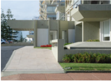
Figura 2.91. Imagem ilustrando o "concreto falso" na edificação.
