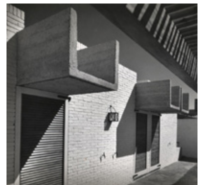
Figuras 3.97. Elementos de concreto em forma de U que auxiliam a manutenção e preservação das esquadrias.
