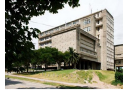
Figura 2.10. Faculdade de Engenharia em Montevideo.
