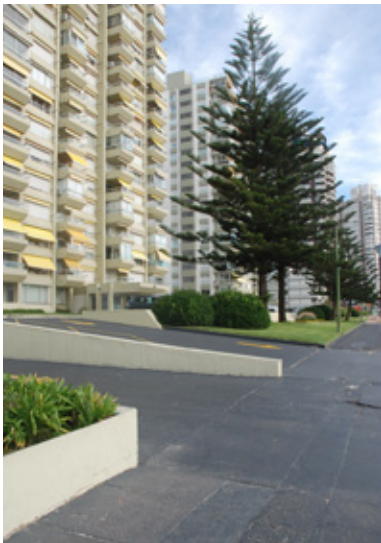
Figura 2.92. Imagem demonstrando o acesso livre do pedestre no interior da edificação, relação essa recorrente nos prédios de Punta del Este.
