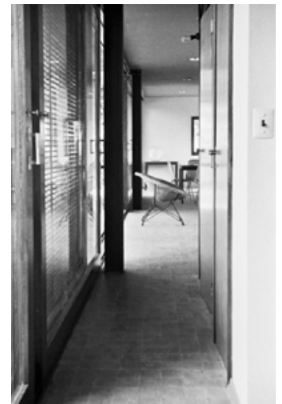
Figuras 3.42. Fotografia da circulação da residência onde aparecem os quatro pilares metálicos delgados próximos às esquadrias. Fonte: Fotografia realizada pelo próprio arquiteto Rodolfo Lópe Rey.
