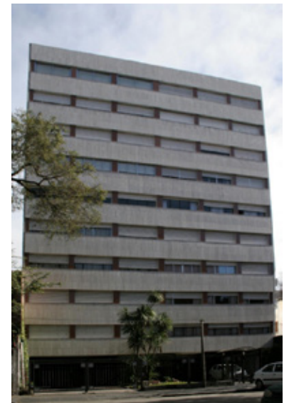
Figura 2.58. Detalhe da fachada do Edifício Corrientes, intercalada entre planos horizontais maciços de concreto e de esquadrias de vidro com persianas.
