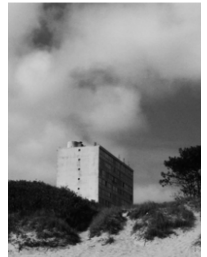
Figura 3.11. - Edifício El Grillo projeto de Luis Garcia Pardo.
