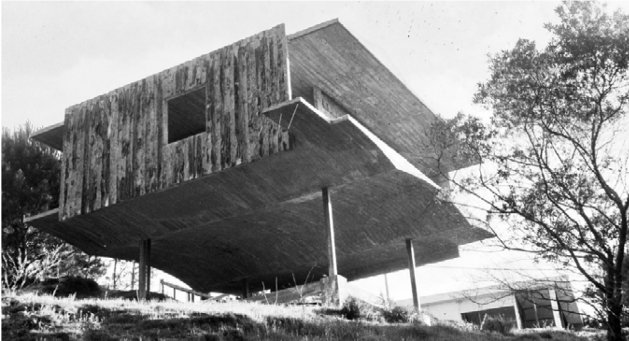
Figuras 3.63. Residência Pepe Suárez. Elevado sobre quatro esbeltos pilares, o corpo principal da residência é formado por um sanduiche de lajes abobadas e com vedação vertical feita de concreto rugoso. Fonte: < http://arquitectolopezrey.com/ >
