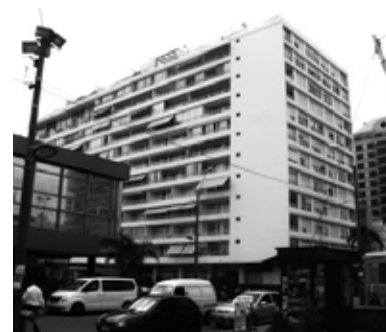
Figura 3.06. - Edifício Península, projeto de Jones Odriozola. Fonte:< https://habitar-arq.blogspot.com/2012/08/punta-del-estemiradas-intensivas.html >
