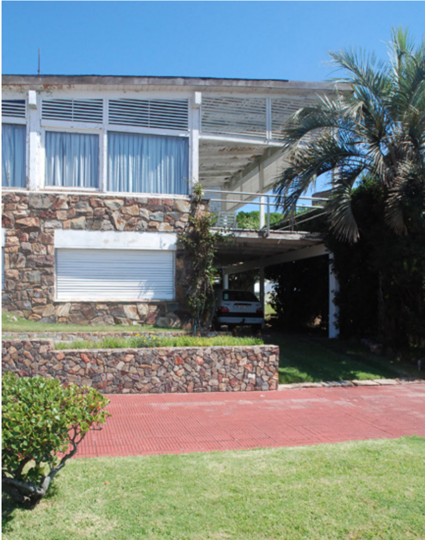
Figura 3.28. - Avarandado localizado na fachada leste, que também configura a cobertura dos veículos.
