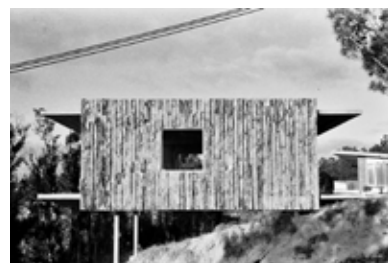
Figura 2.62. Fachada lateral da residência, e seu aspecto bruto através do uso de troncos de eucalipto na forma para a concretagem. Fonte: < http://arquitectolopezrey.com/ >
