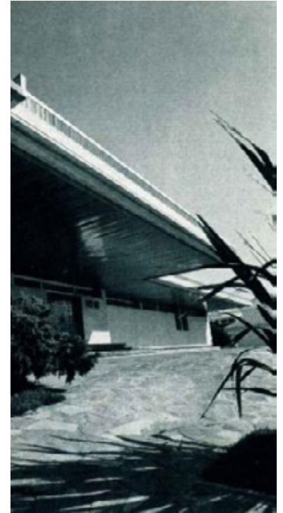
Figuras 3.73. Detalhe do acesso da residência, a imagem ilustra o grande avanço da cobertura que faz a proteção dos veículos.
