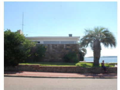
Figura 3.31. - Fachada sul voltada para a rua El Pampero.
