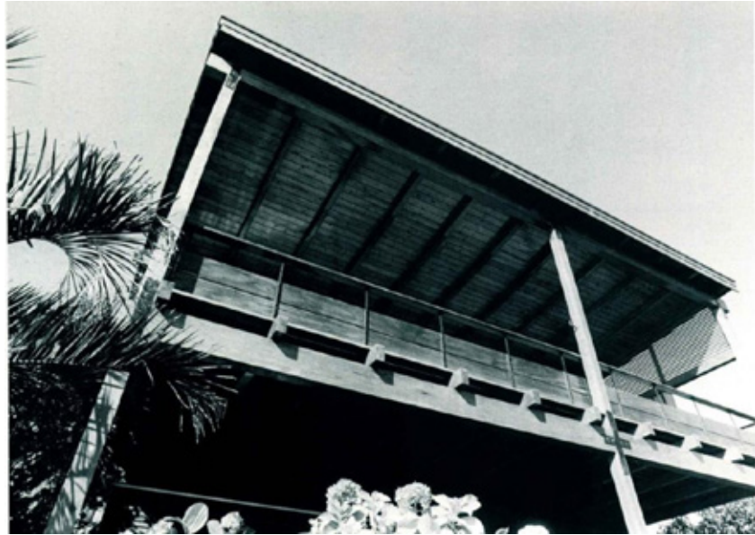
Figura 3.29. - Detalhe da varanda da residência Mailhos Saavedra projetada pelo arquiteto Guillermo Gómez Platero. fotografia extraída da publicação Monografias Elarqa nº8. Fonte:< http://juliogaeta.com/monografico-08/ >
