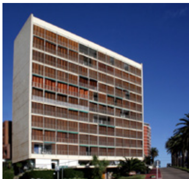
Figura 2.57. Fachada principal da edificação. Percebe-se o dinamismo na fachada através do movimento das venezianas.
