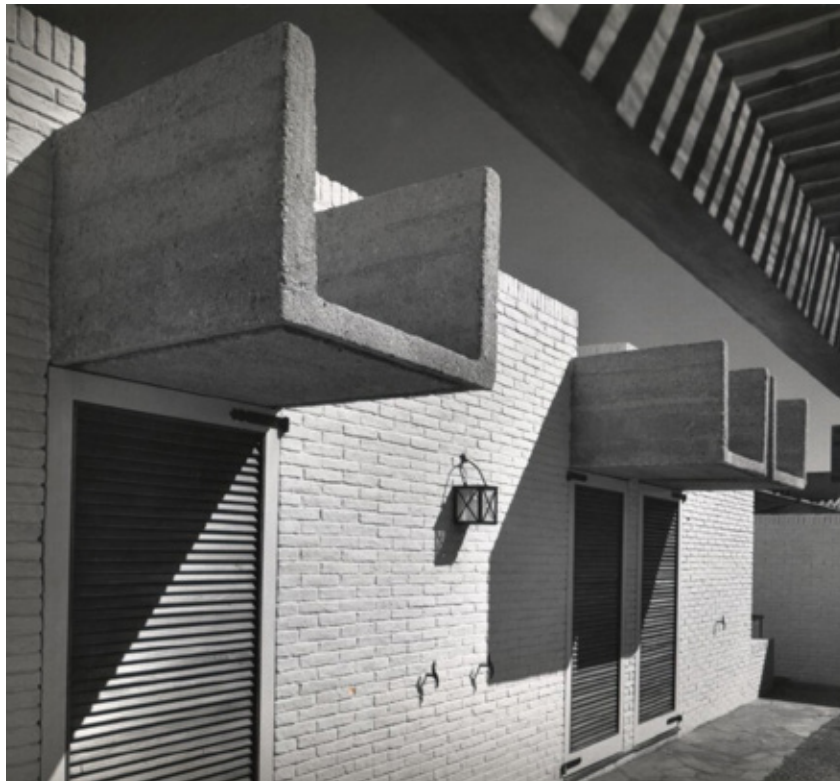
Figura 2.112. Residência La Caldera, detalhe da gargula, preocupação dos arquitetos na conservação das obras do período moderno. Fonte: Arquivo fotográfico de Julius Schulman, Biblioteca de pesquisa no Getty Research Institute, Los Angeles. Fonte: Arquivo fotográfico de Julius Schulman, Biblioteca de pesquisa no Getty Research Institute, Los Angeles.
