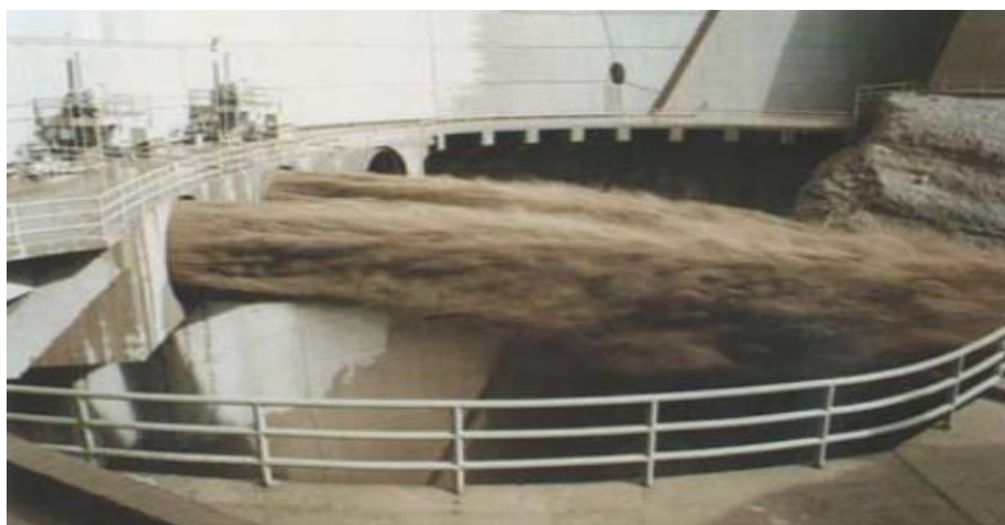
Figura 6: Descarregadores de fundo da represa Dez (Irã) em funcionamento (Fonte: adaptado de Emamgholizadeh et al. (2006)).
