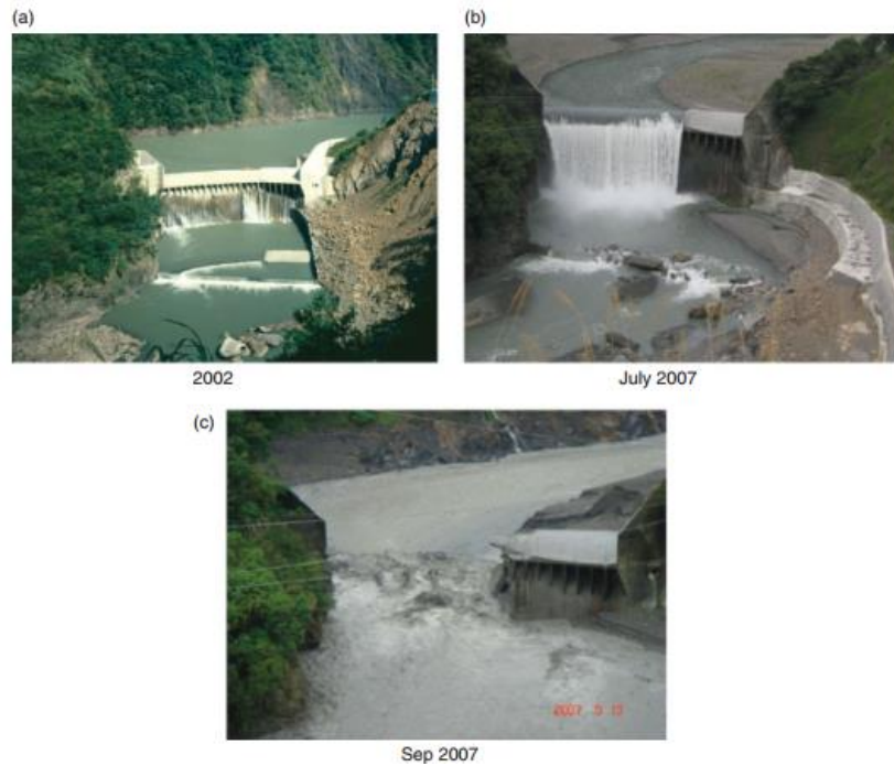
Figura 3: Sequência fotográfica da represa Barlin: (a) antes de sua colmatção (10/2002), (b) assoreada (07/2007) e (c) depois de seu rompimento (09/2007) (Fonte: adaptado de Kondolf et al. (2014)).
