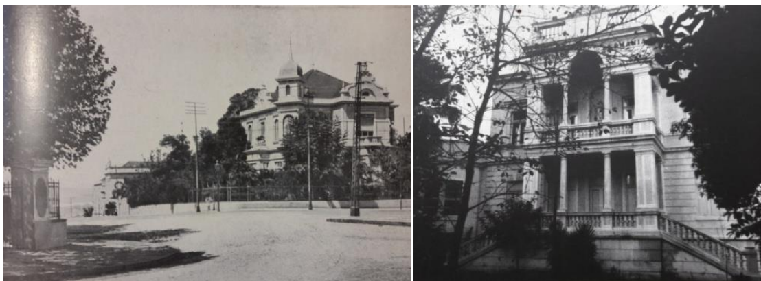
Figura 281: Nova sede do Clube Germânia na Villa Palmaro , na Praça Júlio de Castilhos. Fontes: COSTA, 1922, p.223 e TUBINO, 2008, p.165
