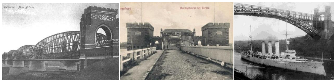
Figura 390: Nova ponte ferroviária em Dirschau. Fonte: www.pobdydgosku.pl , acesso 05.2017
