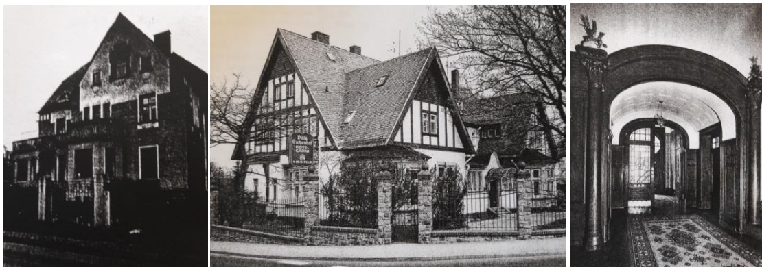
Figura 474: H. Weszkalnys: Villa Rudolf Becker, Hauptstrasse 123, Birkenfeld. Fonte: Stadtverwaltung Idar-Oberstein.
