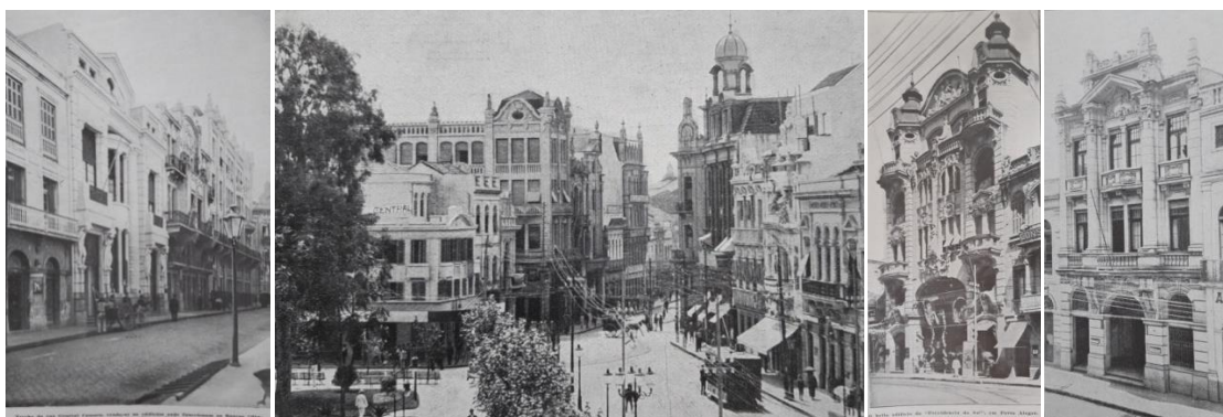
Figura 296: Rua Gen. Câmara: Deutsche Bank für Süd-Brasilien, 1910 (fundação do banco 1904); Edifício Pedro Chaves Barcelos, 1911 (anexo ao Palácio Chaves) e Palácio Chaves com a Confeitaria Colombo, na esquina da Andradas, 1909; todos Ahrons/Wiederspahn. Fonte: COSTA, 1922, p.216
