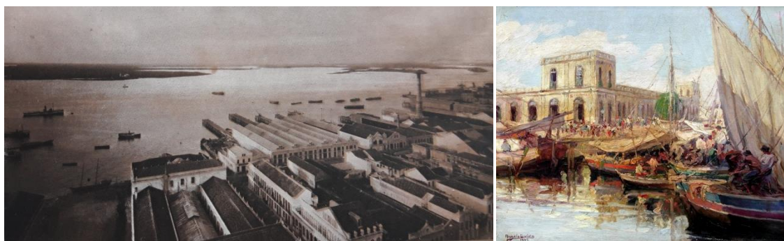
Figura 288: Os cais com trapiches de empresas, logo antes da execução do projeto de Ahrons em 1911. Fonte: COSTA, p.187
