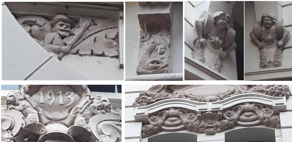
Figura 719: Detalhes da fachada da Previdência do Sul. Fonte: fotos da autora, 03.2017
