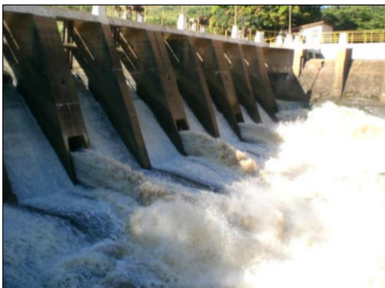
Figura 9 - Descarregadores de fundo da UHE Jacutinga (MG) em operação (CEMIG GT apud KANASHIRO 20-?).
