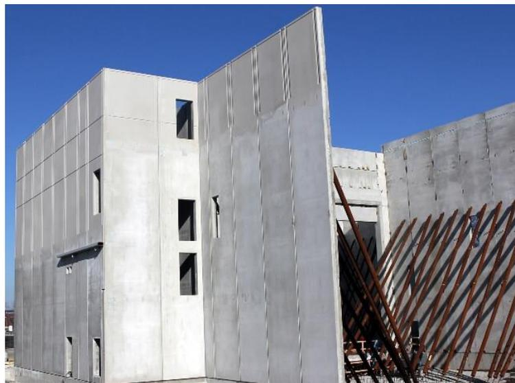
Figura 1.5: painéis de concreto armado (NPCA, 2018).
