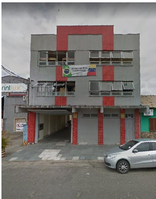
Figura 9. Fachada do Abrigo Centro Humanitário Nossa Gente.
