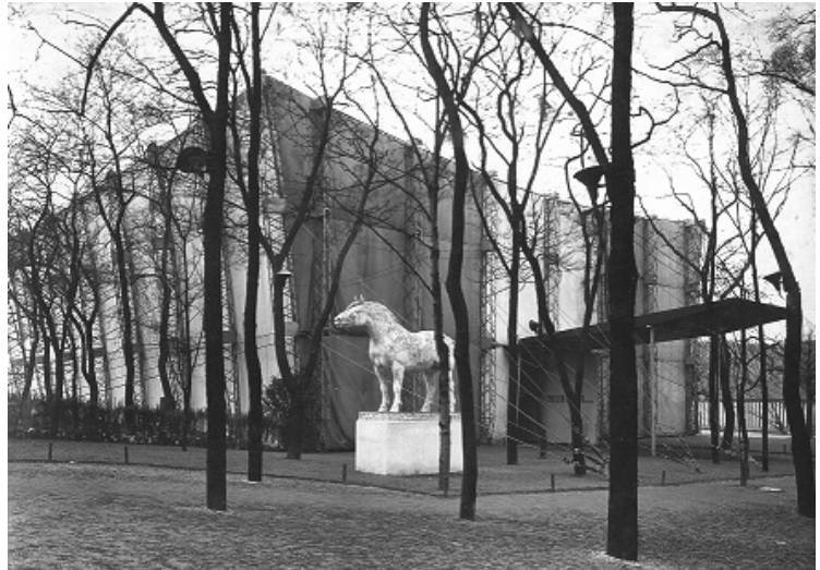
Figura 24 – Vista acesso ao Pavilhão dos Tempos Modernos. Documento L2-13 79.
