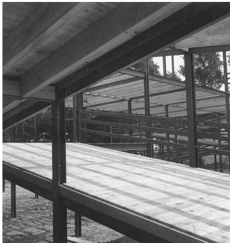
Figura 25 – Estrutura das plataformas em construção. Documento L2-13 59.
