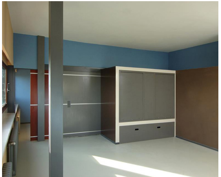
Figura 34 – Armário para guardar as camas e divisórias móveis para compartimentação dos ambientes.
