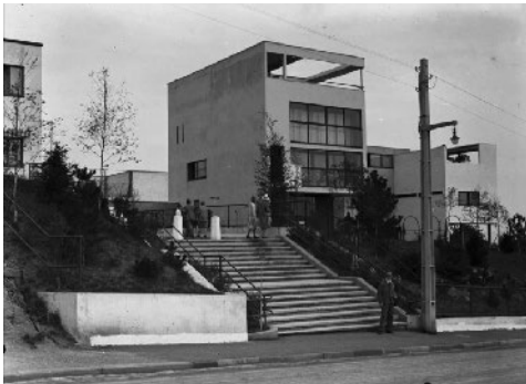
Figura 18 – Acesso lateral Habitação Unifamiliar.
