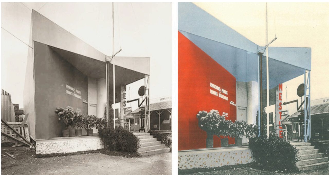
Figura 8 – Fachada lateral e Fachada lateral em cores.
