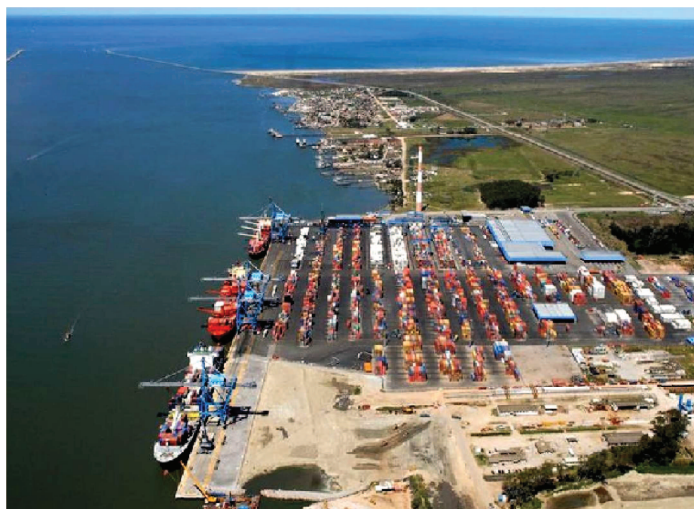
Figura 4.7 – Terminal de Contêineres, Superporto do Rio Grande (SUPRG, 2011).
