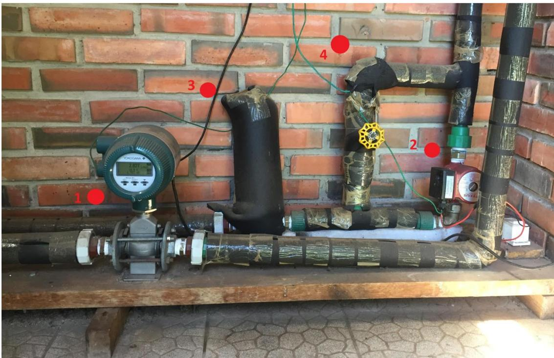
Figura 3.10 – Componentes do circuito hidráulico: medidor de vazão (1), bomba (2), filtro (3) e *by-pass* com válvula gaveta (4).
