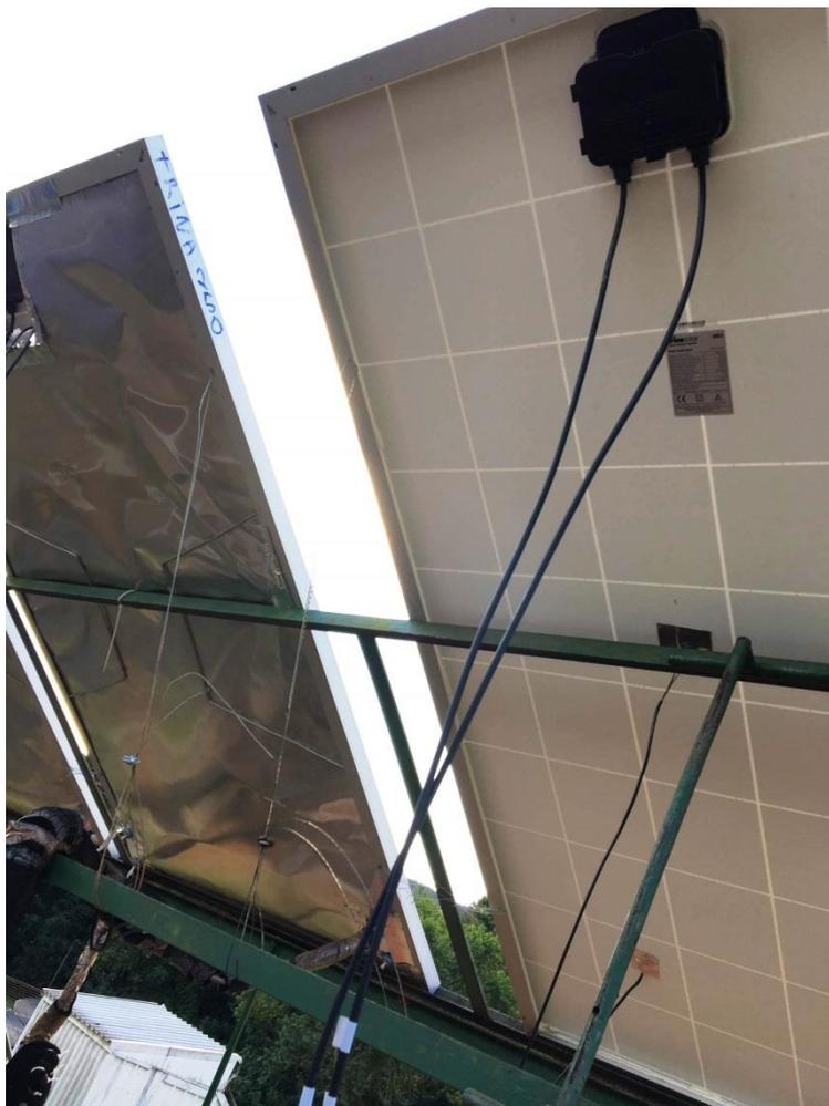
Figura 3.6 – Módulo PVT e módulo FV vistos por trás.
