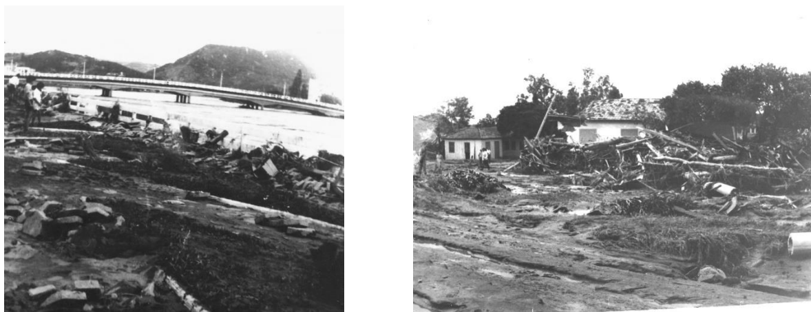
Figura 9 – Lodo, troncos e entulhos depositados em Tubarão. Fonte: Patrimônio Histórico Municipal.
