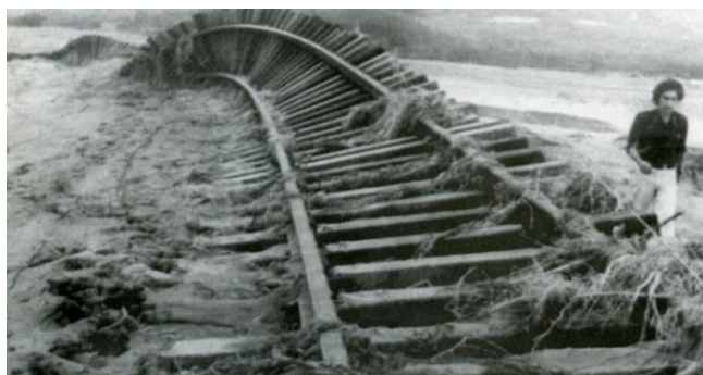
Figura 10 – Trilho da ferrovia retorcido pela força das águas do Rio Tubarão. Fonte: Patrimônio Histórico Municipal.
