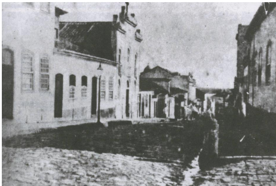
Figura 7 – O esgoto à mostra da antiga Rua de Bragança (atual Marechal Floriano) no século XIX. Fonte: PESAVENTO, Sandra Jatahy. O Espetáculo da Rua. 2.ed.Porto Alegre: Ed. da Universidade, UFRGS, 1996. p.25.
