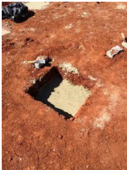
Figura 3.23: Camada tratada em execução.
