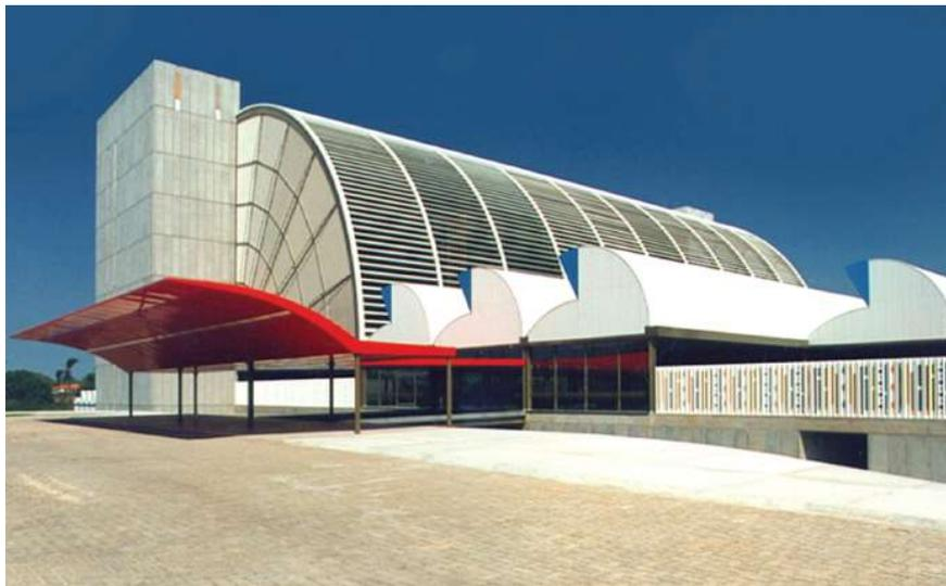
Figura 27: Vista externa do solário com a aplicação de brises para conforto térmico.
