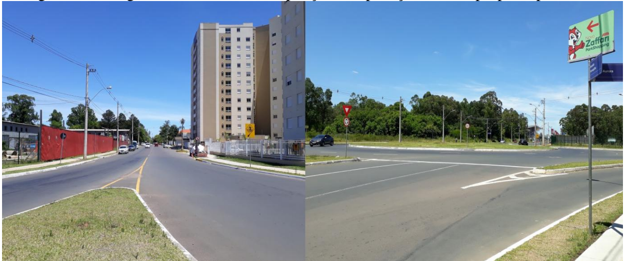
Figura 25 - Imagens da Rua Aurora: ampliação e duplicação na área proposta pelo EIV
