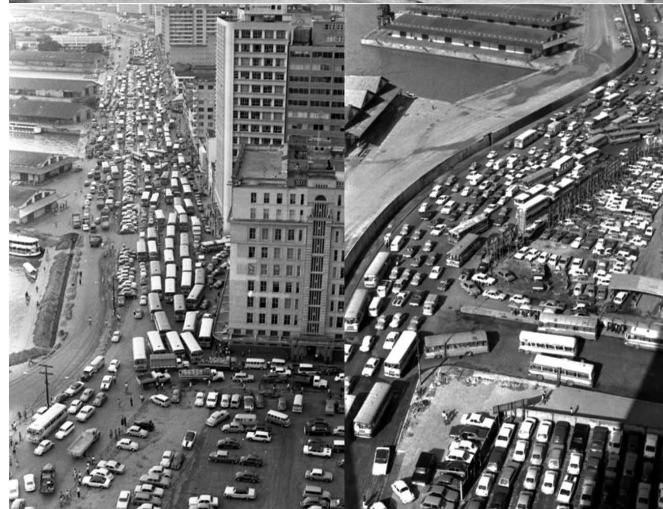
(64) Problemas viários antes do muro
