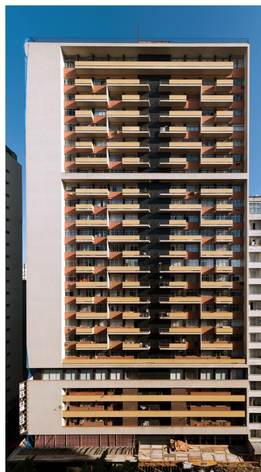
(29) no Edifício Jaguaribe em Porto Alegre, o cinema na base do prédio está desativado.
