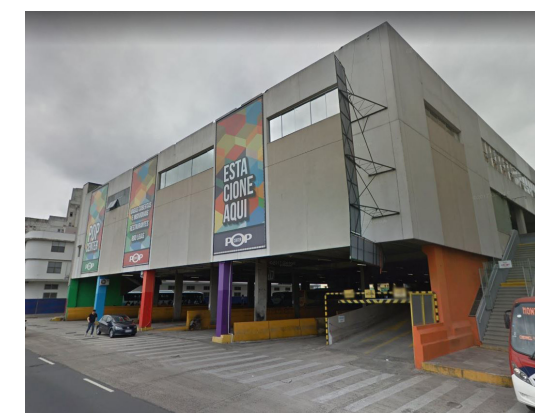
(78) O camelódromo: em termos oficiais o endereço dessa edificação ainda é na Praça Rui Barbosa.
