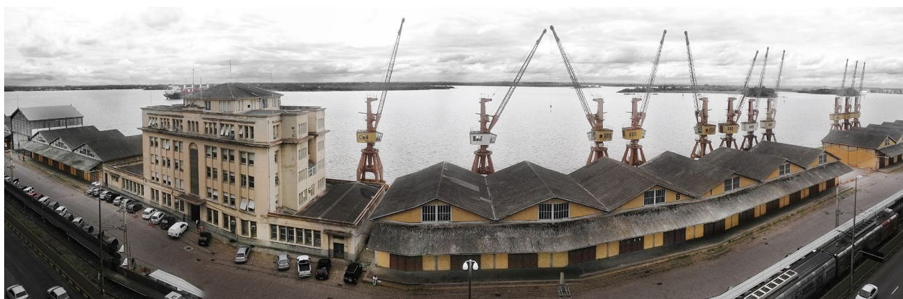
(3) Vista de edifício garagem na Avenida Mauá.
