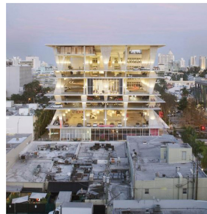
(114) O edifício é um mirante para Miami Beach
