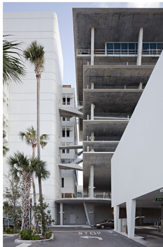
(117) Conexão entre os prédios por escadas passarelas, vista pela Lincoln Lane
