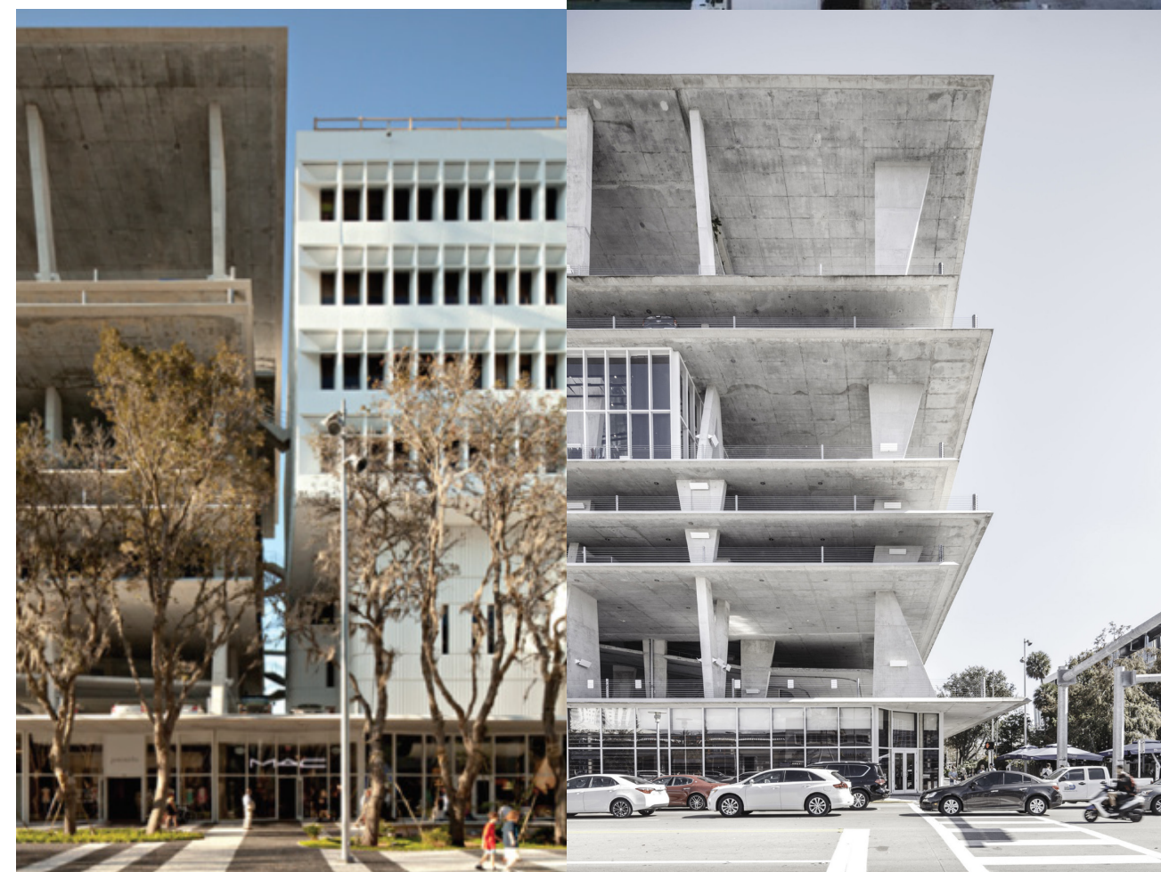
(115) Conexão com o antigo edifício através de escadas-passarelas
