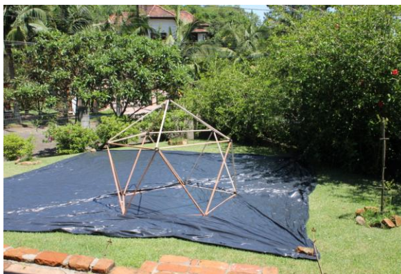
Figura 79 – Preparo para o corte da cobertura.
