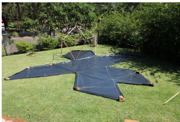
Figura 81 – Corte da cobertura.
