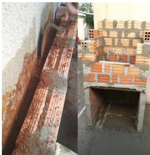
Figura 11 - Colocação do barro por detrás da churrasqueira
