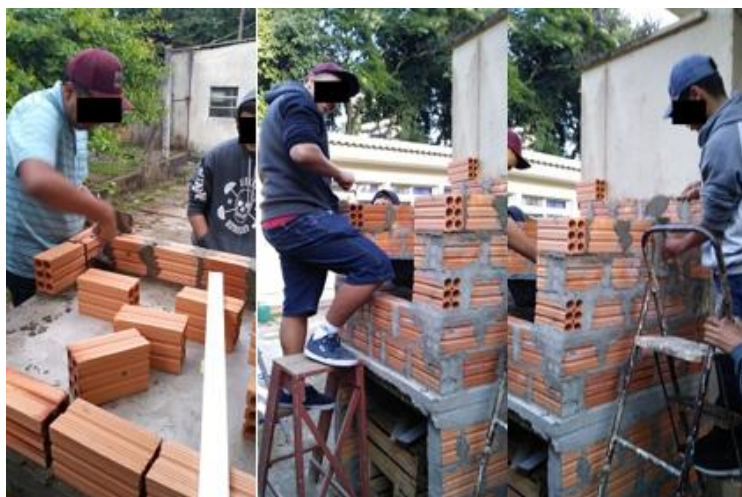
Figura 10 - Construção da parte superior da churrasqueira
