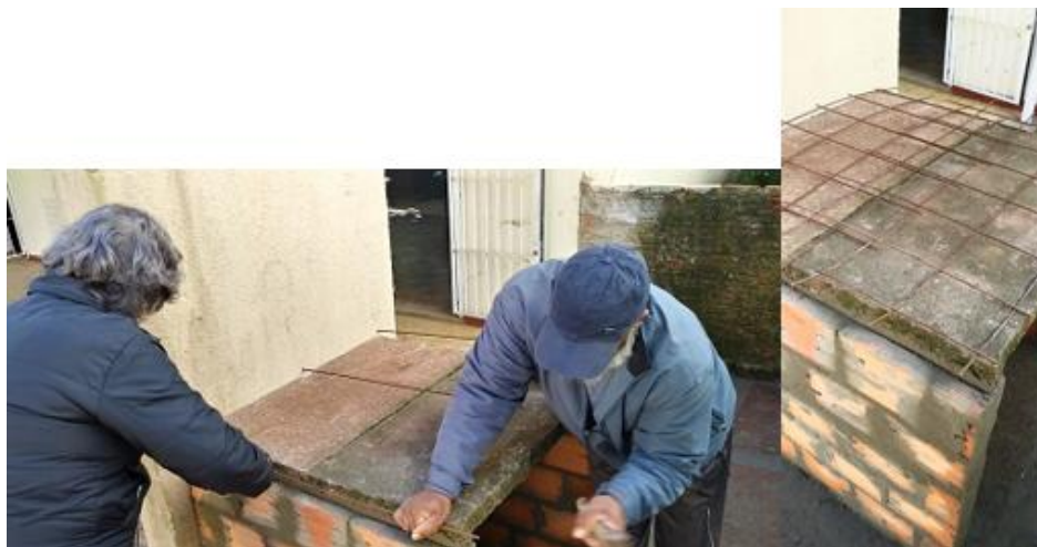
Figura 7 - Colocação da malha de ferro e dos vergalhões 9
