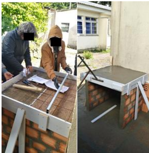
Figura 9 - Construção da caixa de madeira
