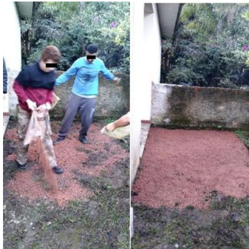
Figura 3 – Cobertura do terreno com britas
