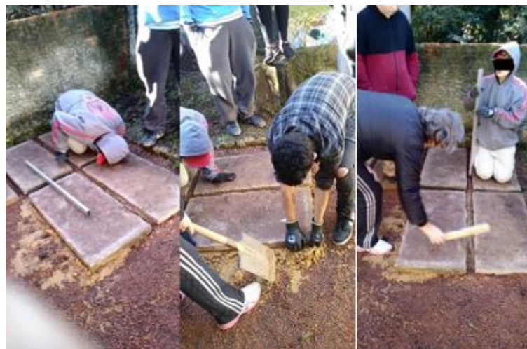
Figura 4 – Colocação das pedras grês e utilização do nível
