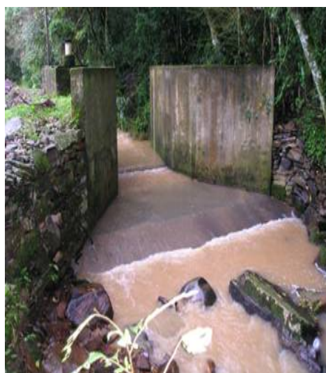
Figura 3.9: Calha Parshall de concreto.
