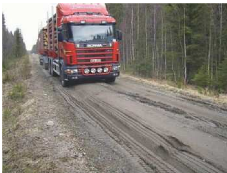
Figura 21: Ilustração do defeito trilha de roda
