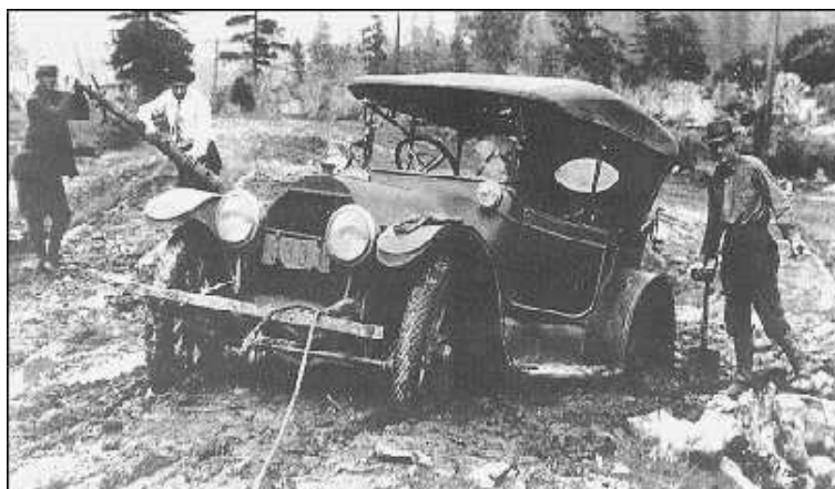
Figura 20: Ilustração do defeito atoleiro
