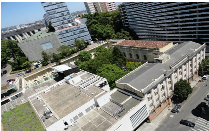
Foto aérea do conjunto arquitetônico do APERS.
