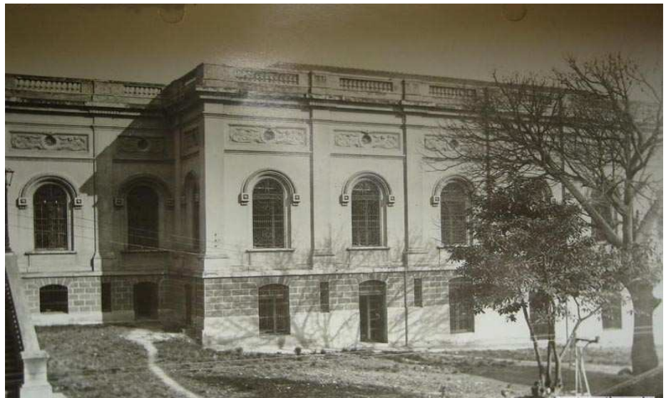
Foto da ala esquerda do Arquivo Público do Estado do Rio Grande do Sul. 2ª fase. Ano 1920. Prédio 2. Fonte: Família Prati
