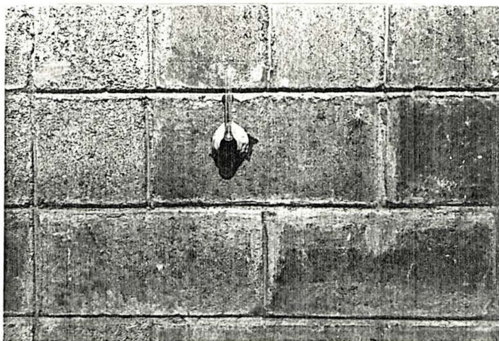
FOTO 8 - Utilização do Método do Cachimbo para verificação da absorção d'água das paredes dos blocos de apartamentos (sem revestimento) do Núcleo Habitacional Ildo Menegheti.
