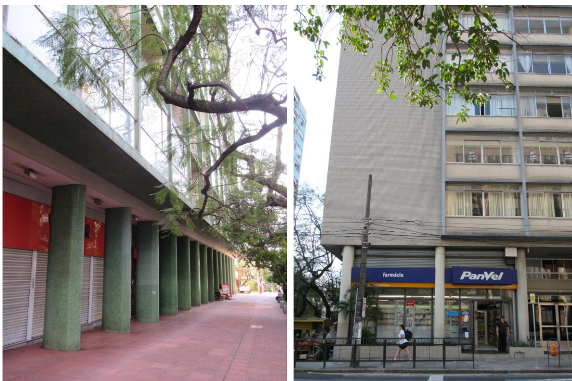
Figura 4.16 – Pilotis e Lojas do Edifício Esplanada (Román Fresnedo Siri - Ano 1952).
