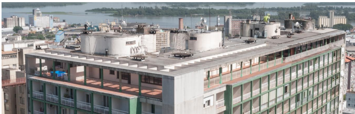
Figura 4.13 – Superestrutura e Áreas de Lazer Condominial no Edifício Esplanada. (Fonte: https://www.archdaily.com.br/br/790990/arquitetura-moderna-em-porto-alegre-antecedentes-e-a-linhagem-corbusiana-dos-anos-50-luis-henrique-haas-luccas?ad_medium=gallery ).
