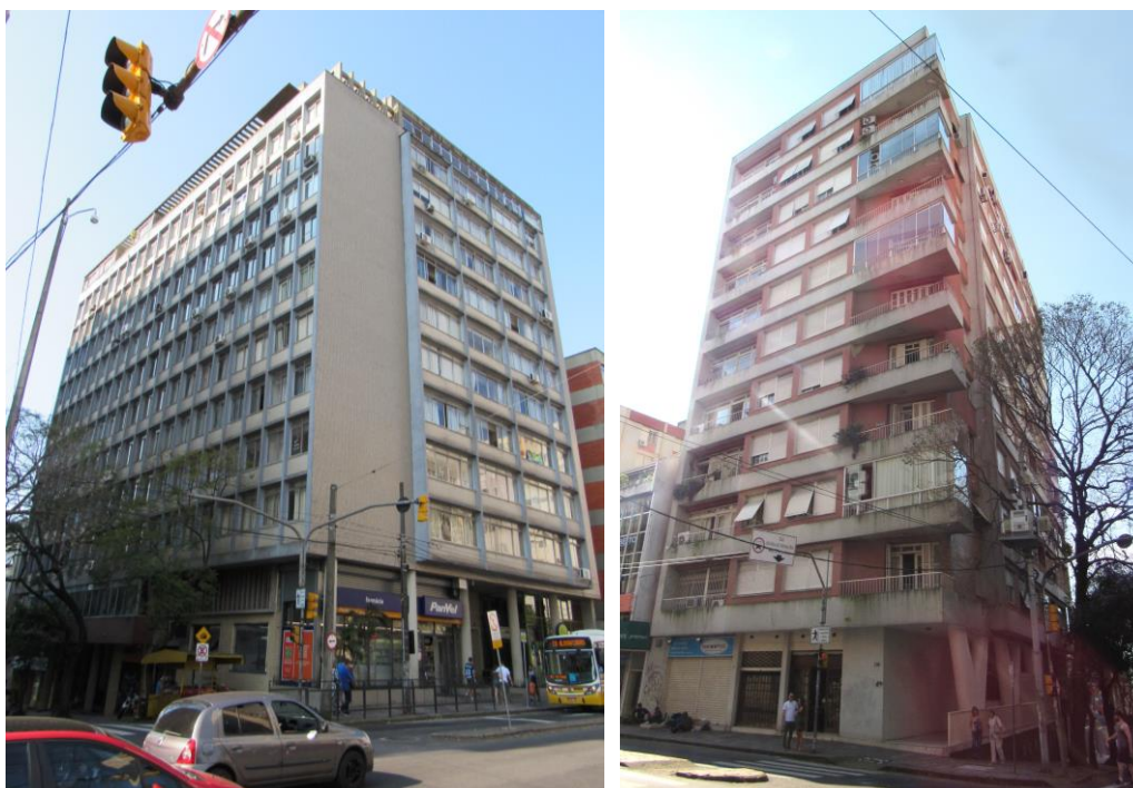
Figura 4.2 - Edifício Paglioli, projeto de Remo José Irace e Miguel Irace (Ano 1957). Figura 4.3 - Edifício José Pilla, projeto de Max Warchavski e Moacyr Marques (Ano 1958). (Fontes: Acervo de Rodrigo Petersen).
