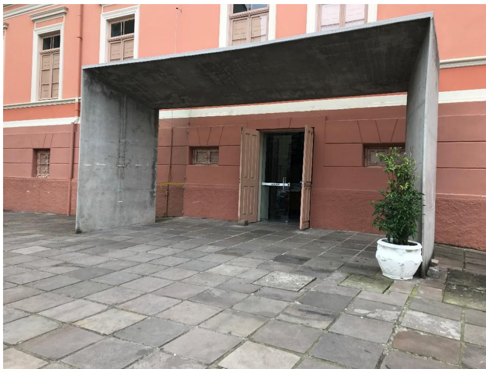
Figura 15 – Acesso utilizado para o Prédio Centenário
