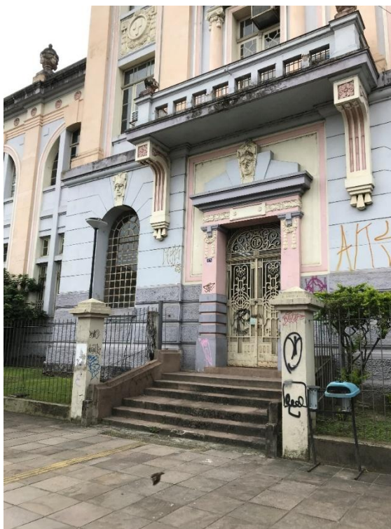
Figura 23 - Entrada principal não utilizada
