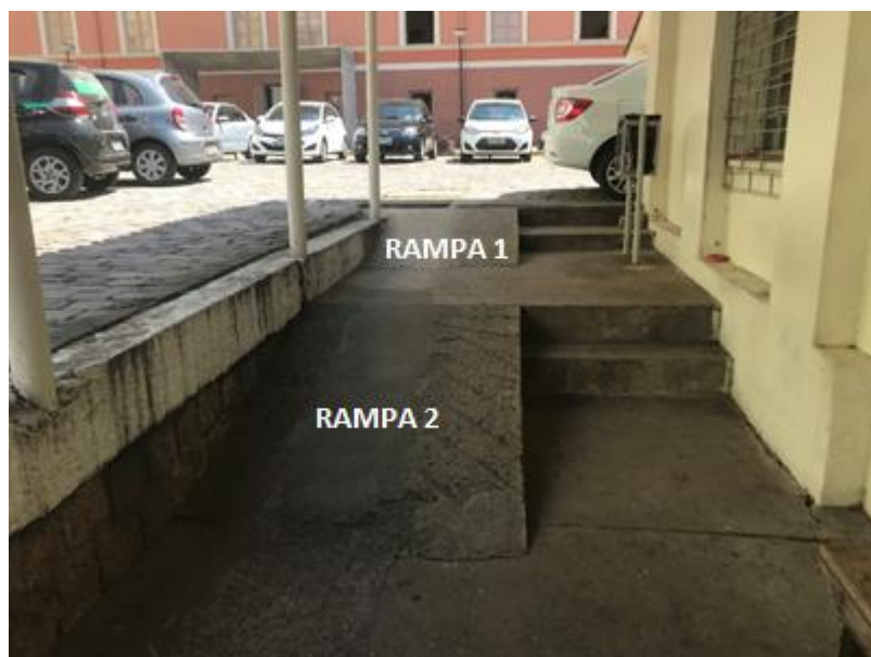
Figura 42 - Rampas Prédio Manutenção Terceirizado, ao fundo o prédio Centenário da EE
