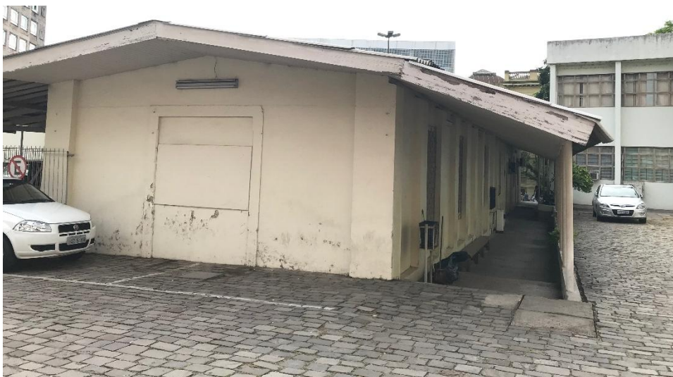
Figura 28 - Prédio Manutenção Terceirizados
