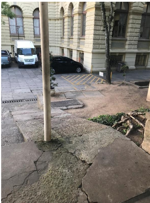
Figura 41 - Rampa Prédio Manutenção
