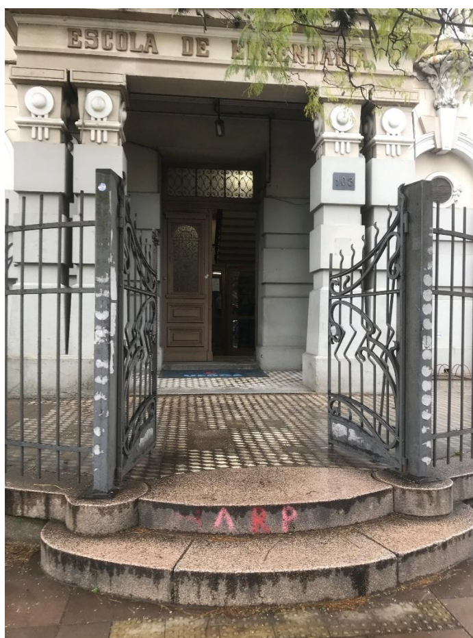
Figura 38 - Frente do Instituto Eletrotécnico
