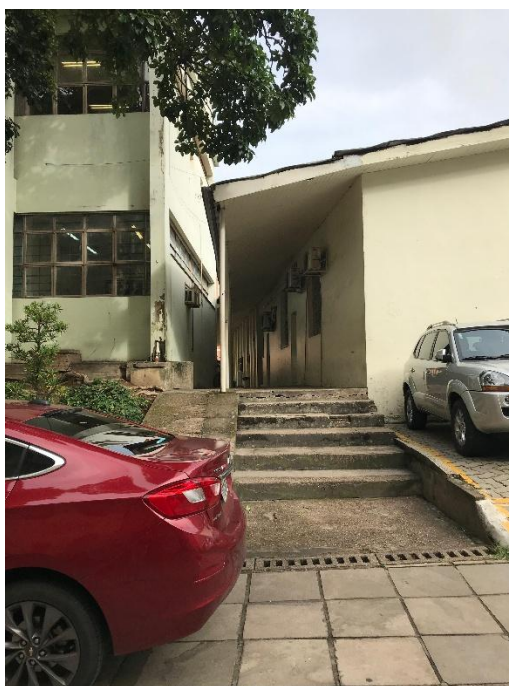
Figura 40 - Acesso Prédio Manutenção
