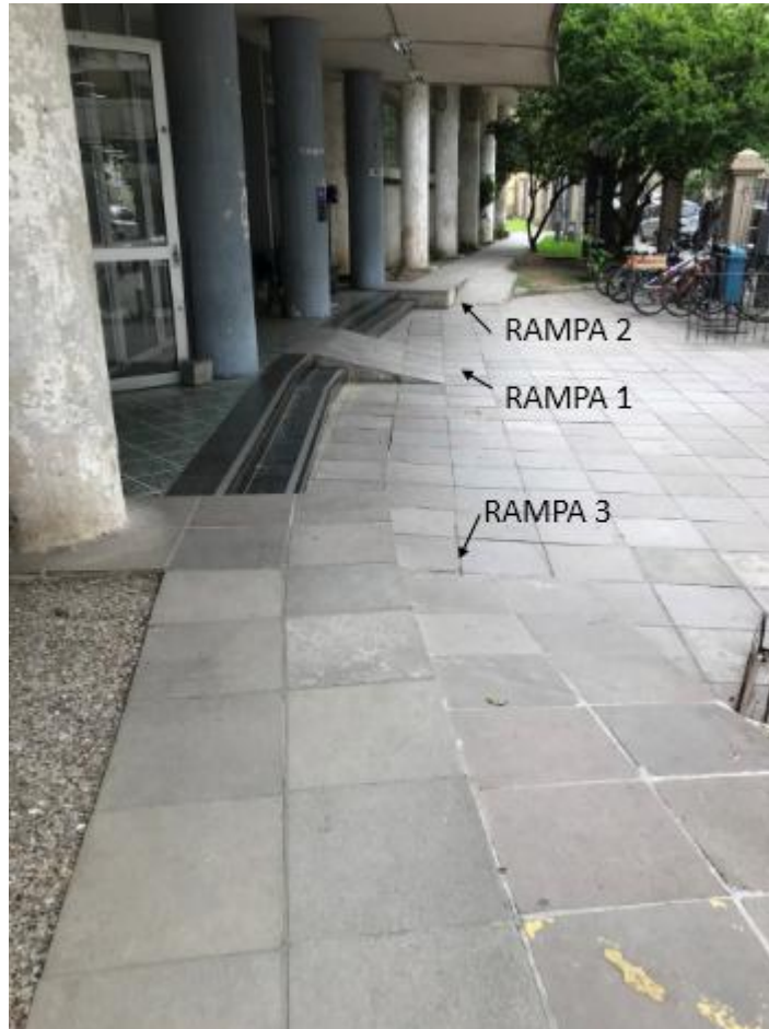
Figura 31 - Rampas 1, 2 e 3 do prédio novo da EE
