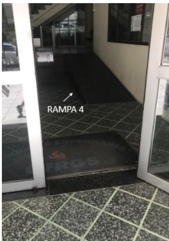
Figura 32 - Rampa 4 EE Nova
