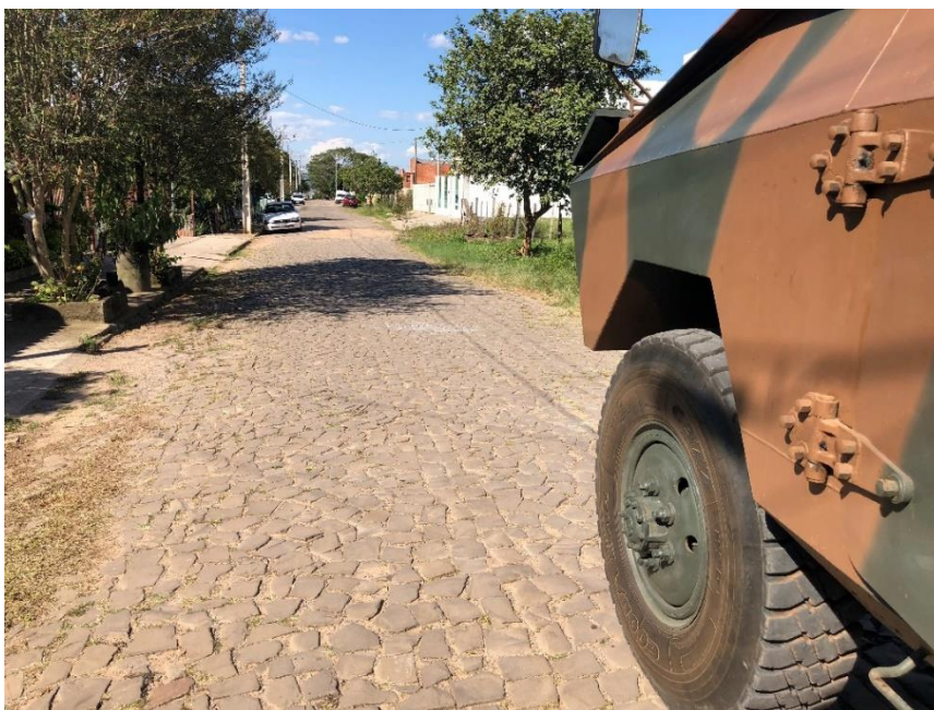
Figura 4.4 - Pavimentação do bairro Boi Morto em Santa Maria/RS, próximo ao CI Bld, composta por blocos de paralelepípedos irregulares (parte do trajeto de medição).
