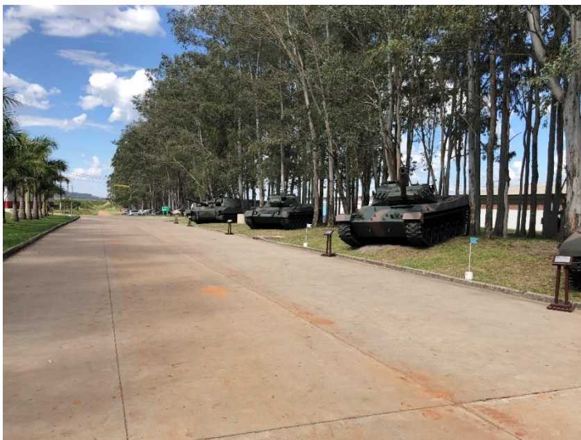
Figura 4.3 - Pátio interno do Centro de Instrução de Blindados composto por pavimentação rígida de placas de concreto armado, na qual foram realizados os testes com os veículos blindados.
