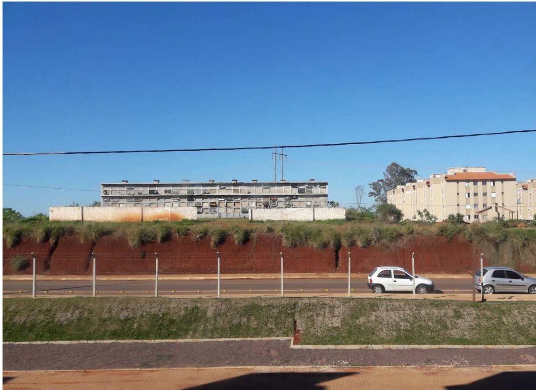
Figura 27 – Vista do apartamento sobre o conjunto vizinho, o cemitério e a linha de alta tensão
