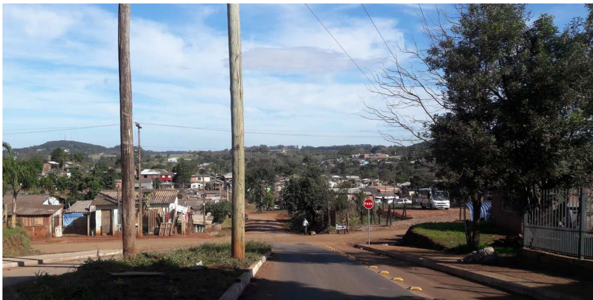
Figura 28 – Fim do asfalto, entrada do bairro Santo Antônio
