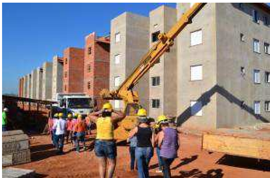
Figura 10 – Obras de infraestrutura no bairro
