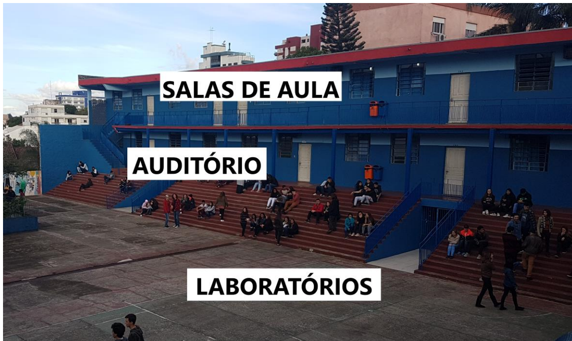
Figura 4: Pátio central da escola A
