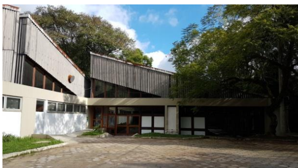
Figura 73. Acesso secundário do RU3 com rampa de acessibilidade em execução. Fonte: imagem fotografada pela autora (2018).
