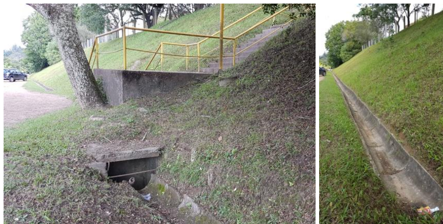
Figura 54. Talude entre o terminal de ônibus e estacionamento no platô superior e detalhe da canalização de drenagem pluvial. Fonte: imagens fotografadas pela autora (2018).
