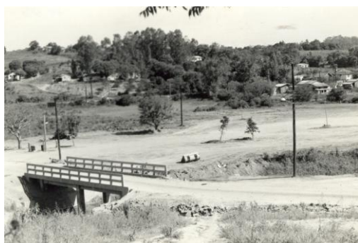
Figura 19. Ponte de ligação sobre a barragem do IPH. Fonte: Acervo fotográfico base digital SPH/SUINFRA/UFRGS (Década de 1970).
