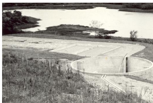
Figura 20. Barragem Mãe D'água, com a construção do reservatório. Fonte: Acervo fotográfico base digital SPH/SUINFRA/UFRGS (Década de 1970).
