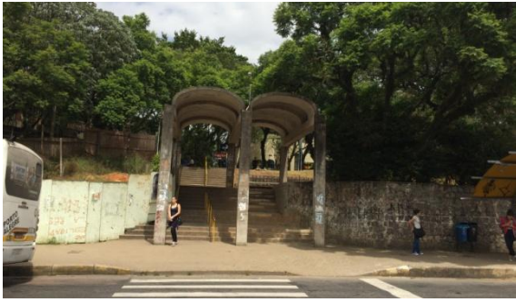
Figura 49. Imagem da escadaria de acesso ao Campus do Vale a partir do Terminal de Ônibus. Fonte: imagem fotografada pela autora (2016).
