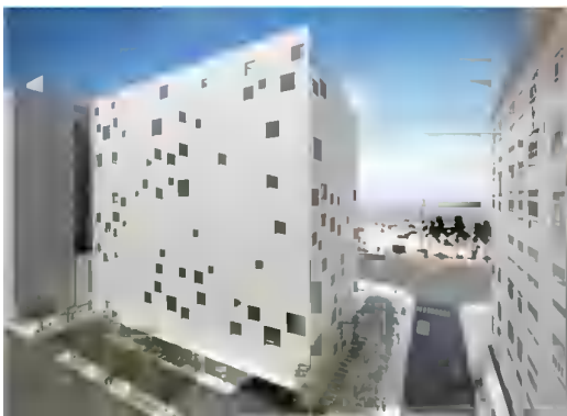
3.1.91 _ Vista da fachada de trás;
