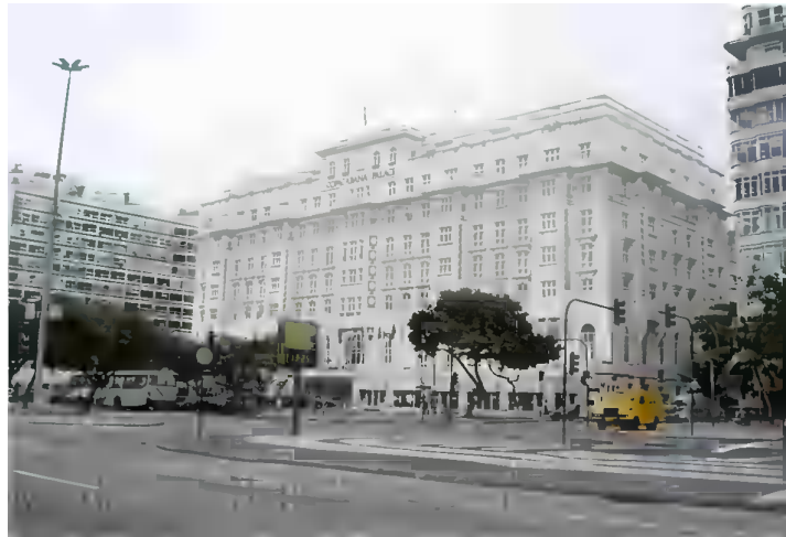
3.1.19 _ Estado atual do Hotel Copacabana Palace, na Av. Atlântica.
