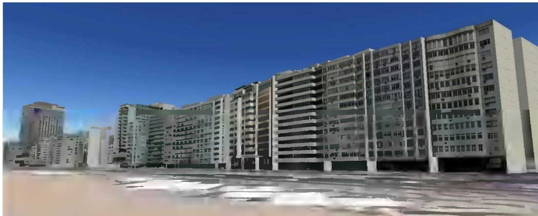
3.1.31 _ Trecho exemplar da continuidade dos conjuntos formados pelos edifícios residenciais;
