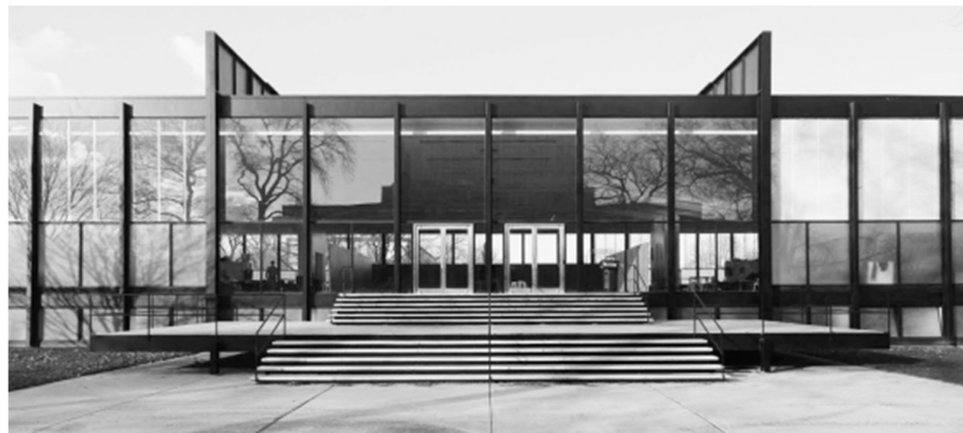
1.6 _ Crown Hall - Mies van der Rohe
