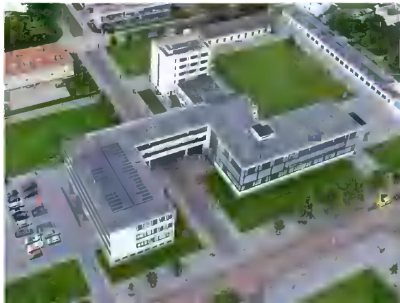
1.7 _ Prédio da Bauhaus em Dessau (1926) - Walter Gropius – vista Aérea – articulação com o entorno;
