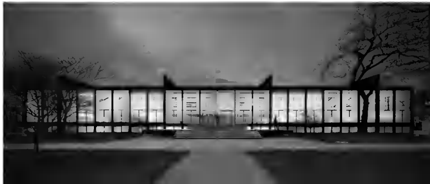
2.4 _ IIT Crown Hall de Mies van der Rohe;
