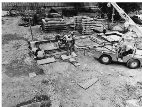
3.46 Processo de pré-fabricação e montagem dos “marcos” das lajes do bloco de galerias expositivas da segunda expansão do MBAC, 1966-76.
