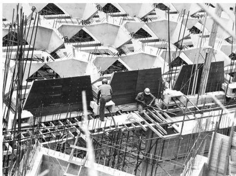
3.47 Processo de pré-fabricação e montagem das “cruzes” das lajes do bloco de galerias expositivas da segunda expansão do MBAC, 1966-76.
