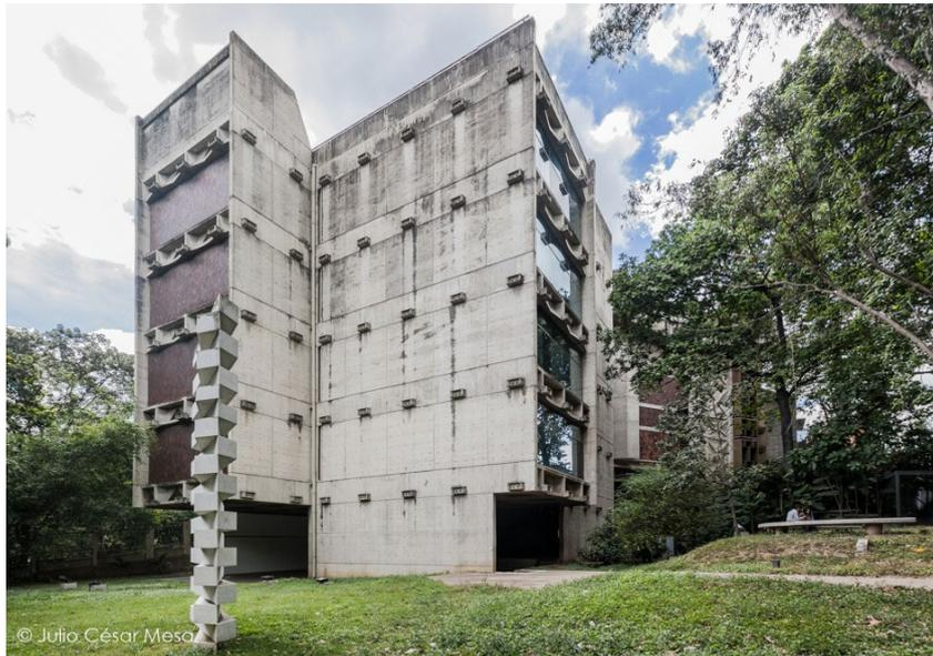
nas fachadas norte, leste e sul. A estrutura é composta por cinco lajes de elementos pré-fabricados em concreto armado, apoiadas em paredes portantes periféricas, de mesmo material, mas moldado *in loco*. O resultado é uma torre amuralhada encravada entre o edifício existente e o Parque Los Caobos.
