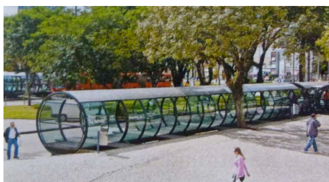
Fotografia 72 – Estação tubular da linha de ônibus expressa, Curitiba, 2011
