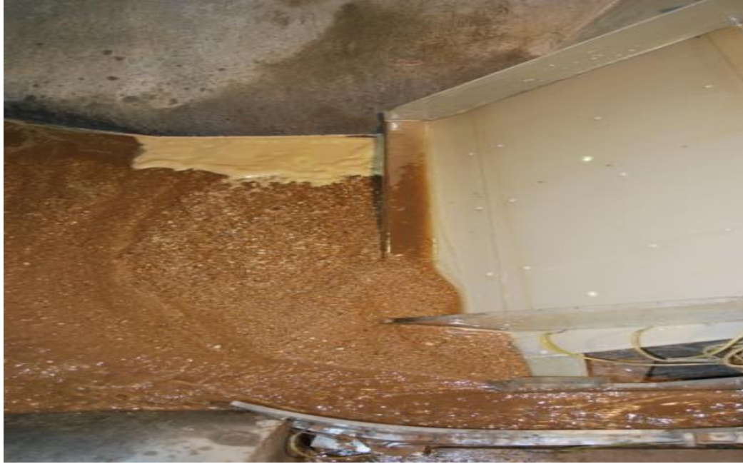
Figura 19: Depósito de sedimento ao pé da barragem Q= 50 \text{ m}^3/\text{s} (MACHADO et al., 2009)
