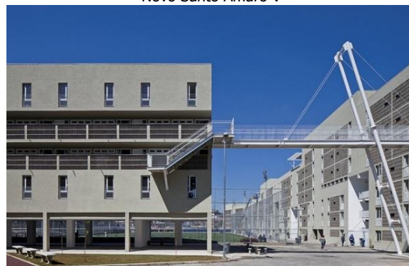
Figura 36 - Foto lateral do conjunto habitacional Parque Novo Santo Amaro V
