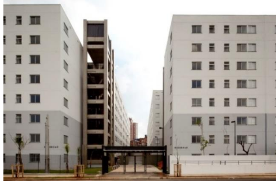
Figura 46 - Foto lateral da habitação conjunto Comandante Taylor
