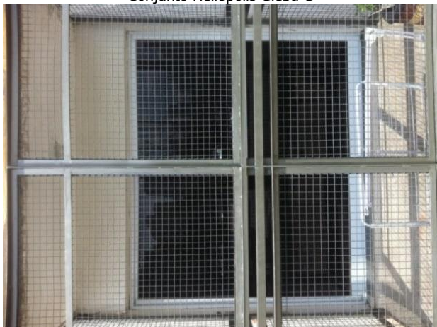
Figura 161 – Janela (vista externa) dos apartamentos estudados do Conjunto Heliópolis Gleba G
