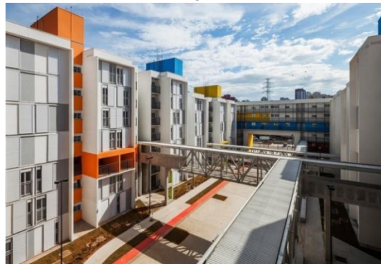
Figura 41 - Foto lateral da habitação Conjunto Heliópolis Gleba G
