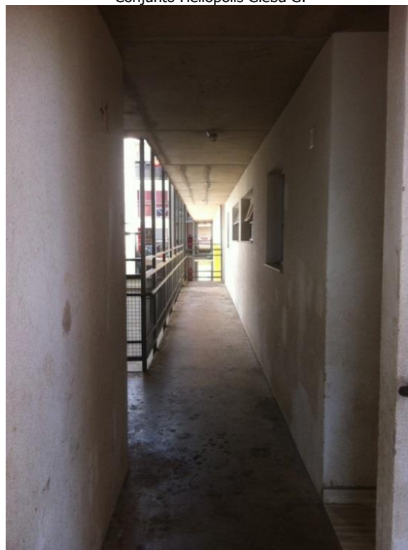
Figura 57 - Corredor de acesso do apartamento 04 no Conjunto Heliópolis Gleba G.
