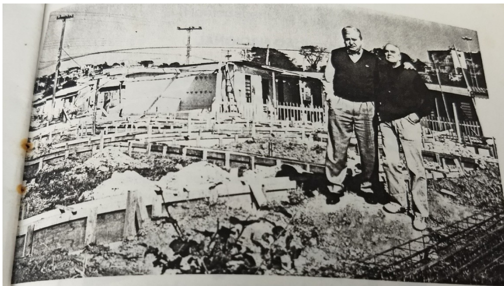
Figura 12 - Canteiro de obras da IEL Jequitibá, presente no relatório de Diretoria Lions Clube Barão do Cahy
