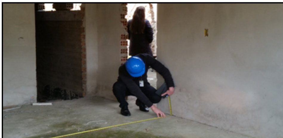
Figura 8 - Vistoria em obra do Proinfância
