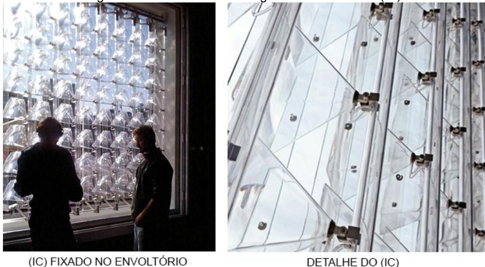
Figura 17 – Sistema solar Integrado em Fachadas (IC).
