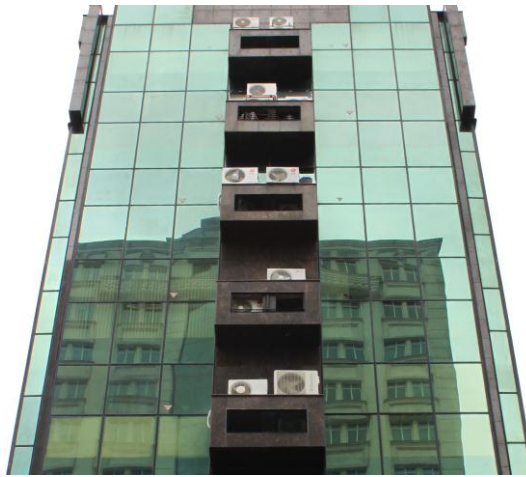
Figura 36 – Ar condicionados na fachada do Edifício de número predial 912.
