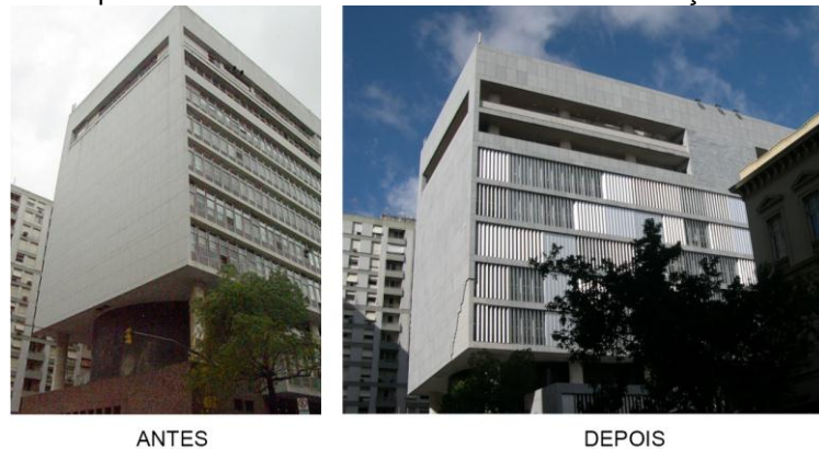
Figura 19 – Dispositivos Verticais fixados no Palácio da Justiça de Porto Alegre.
