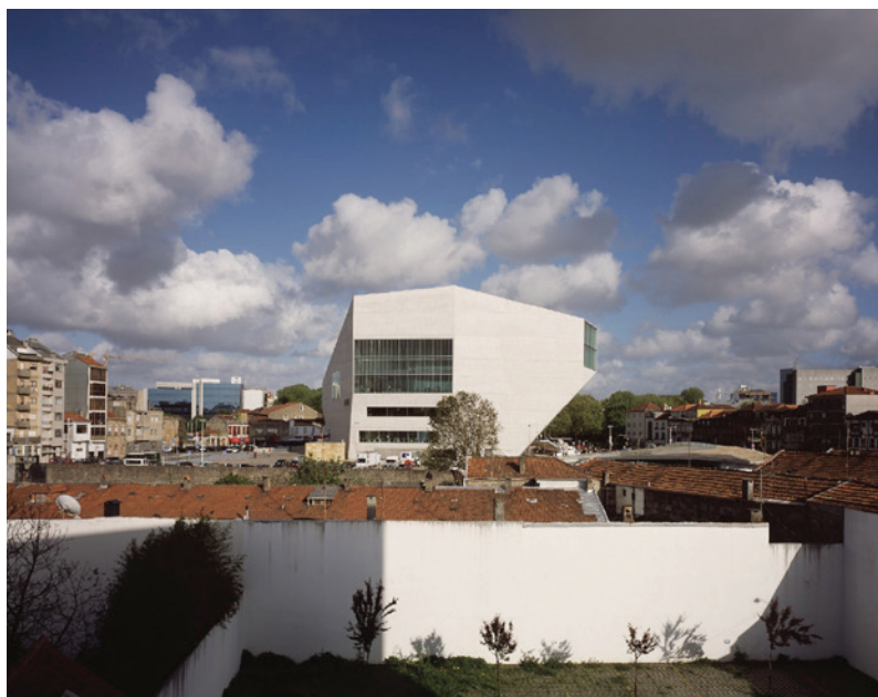
K169. Casa da Música logo após construída. Fachada noroeste.
