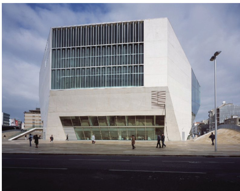
K168. Casa da Música logo após construída. Fachada sudeste.
