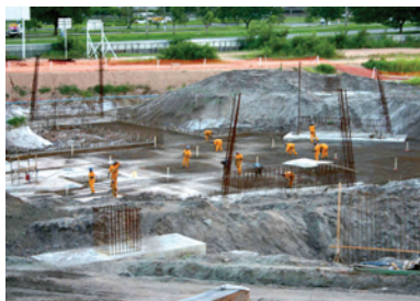
P108. Limpeza do terreno e construção das fundações, 2004.
