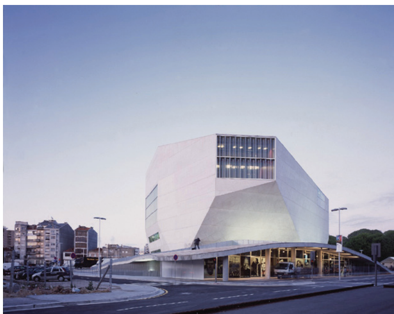
K170. Casa da Música logo após construída. Fachada sudoeste.
