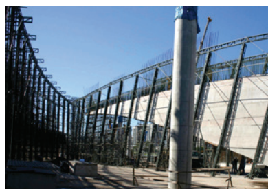
P112. Construção do pilotis (NO). Colunas e pórticos.
