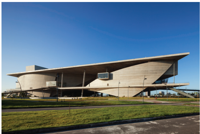
P154. Fachada norte. Vazio entre sólidos.
