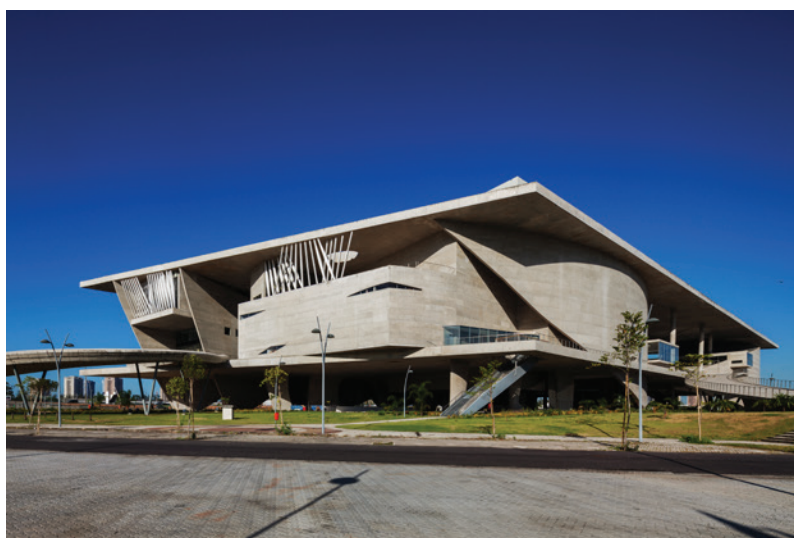
P126. Vista das fachadas norte e nordeste.
