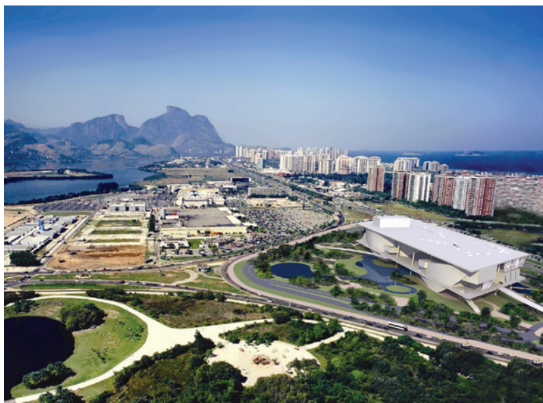
P059. Desenvolvimento do anteprojeto da Cidade das Artes. Rio de Janeiro. Christian de Portzamparc/ACDP. Perspectiva eletrônica mostrando o edifício no contexto.
