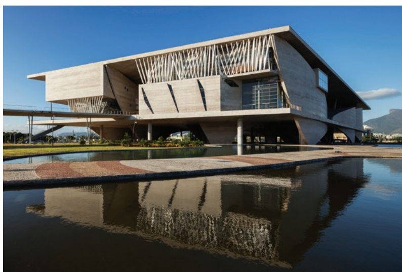
P124. Vista das fachadas sul e sudoeste.
