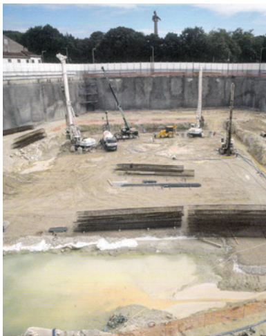
K155. Subsolo em construção.
