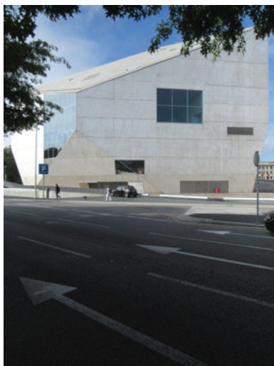
K206. Vista a partir da esquina da Rua de 5 de Outubro com Vanzeleres.
