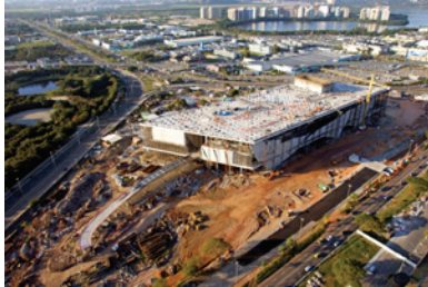
P115. Pilotis e parte da laje da varanda concluídas. Junho de 2007.
