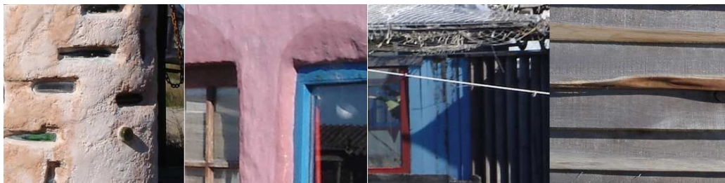
Figura 8: garrafas, janelas, alvenaria, madeira
