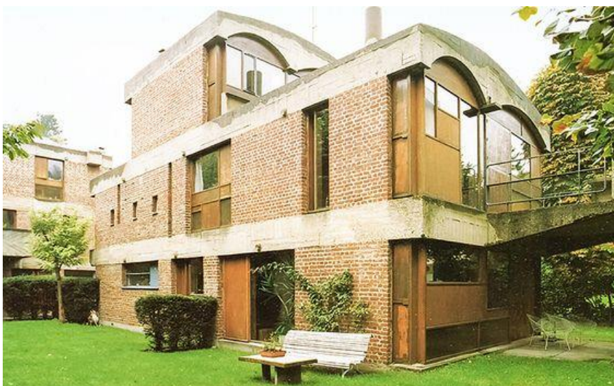
Figura 60: Fachadas Casa B Fonte: William Montgomery (2018)
