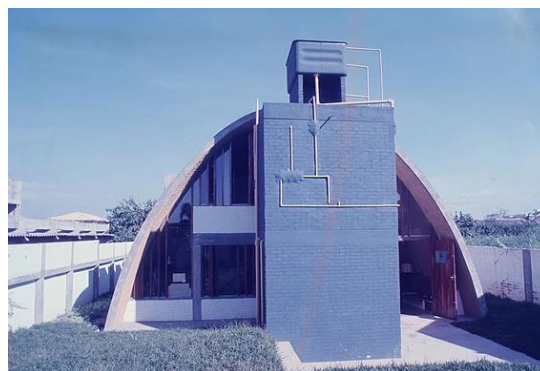
Figura 90: Casa Dino Zamataro Fonte: Arquivo.arq.br (2018)
