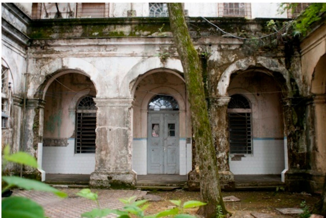
Pátio interno Hospital Psiquiátrico São Pedro – Foto: Bernardo Jardim – Sul 21
