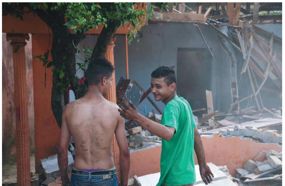
Remoção na Av. Tronco, 07/05/2015. Marcelo Ripoll.
