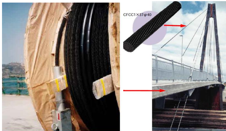
Figura 4 - Cabo comercial CFCC da empresa Tokyo Rope em diversos tamanhos e aplicações [catálogo Tokyo Rope].
