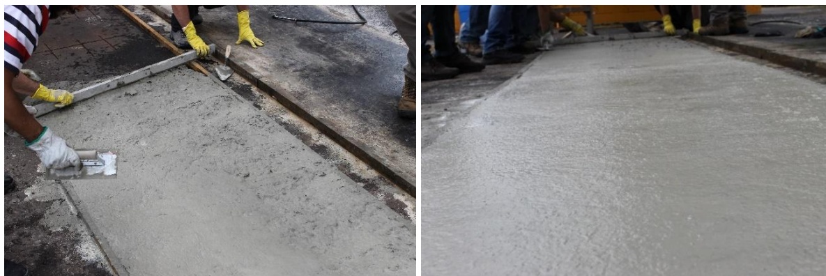
Figura 5.43: Processo de acabamento do recapeamento de 30 mm. Fonte: fotos do autor.
