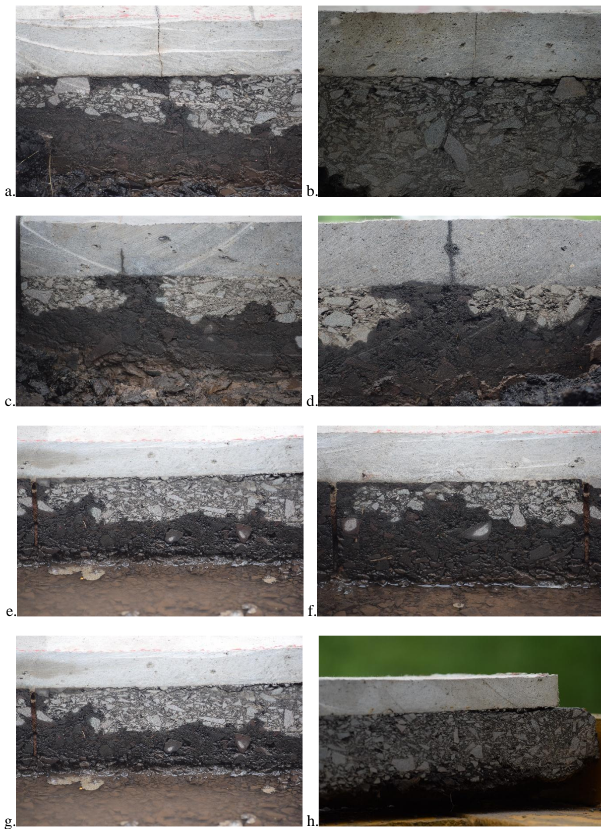
Figura 5.52: Vistas laterais dos cortes executados no recapeamento de 30 mm. Fonte: fotos do autor.
