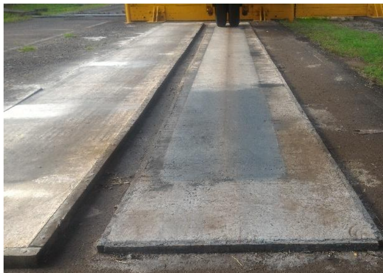
Figura 3.43: Vista dos recapeamentos conformados para os ensaios em verdadeira grandeza: direita 50 mm, esquerda 30 mm. Fonte: foto do autor.
