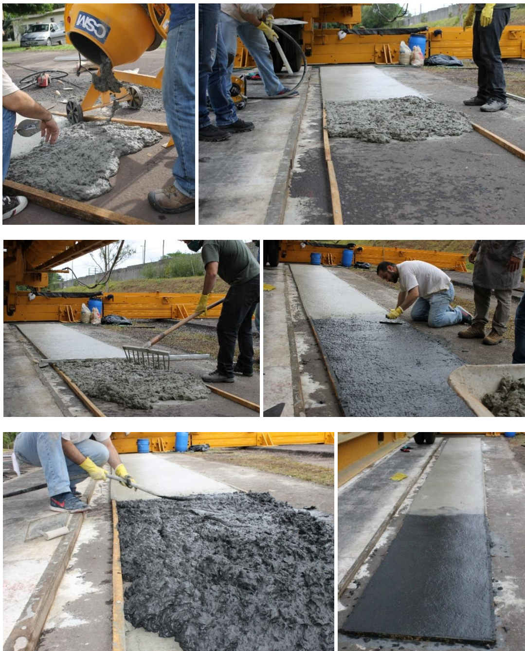
Figura 5.39: Processo de lançamento do material na conformação dos recapeamentos. Fonte: fotos do autor.
