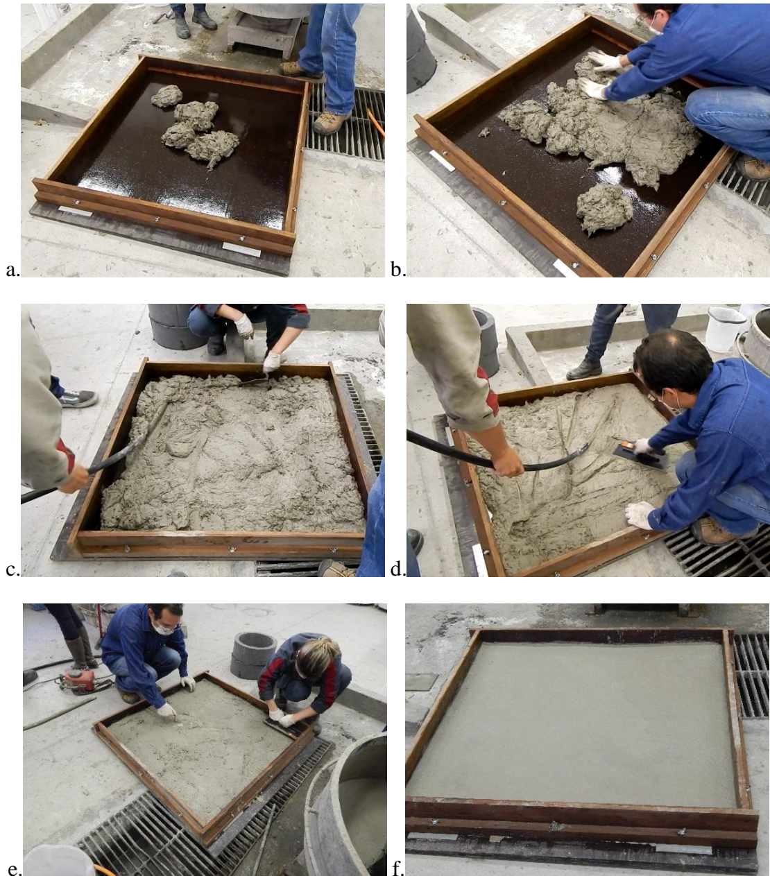
Figura 4.5: Sequência que mostra a acomodação do ECC na forma: (a-b) disposição de material na forma; (c-d) espalhamento e vibração; (e) acabamento final; (f) textura final. Fonte: fotos do autor.
