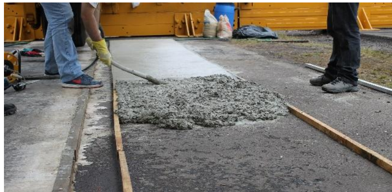
Figura 5.42: Vibrado do compósito na construção do recapeamento de 30 mm. Fonte: foto do autor.
