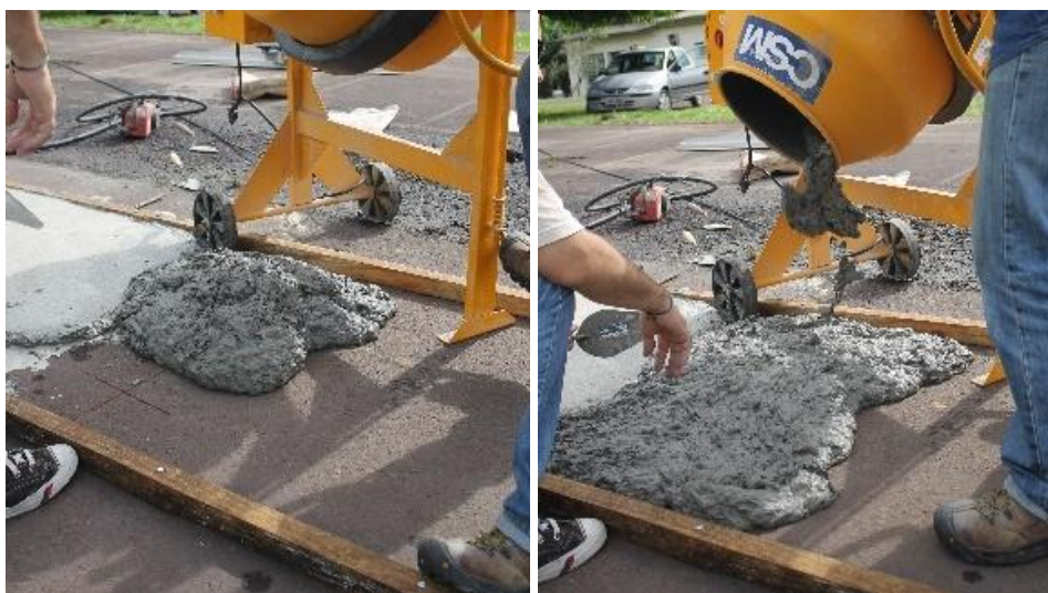
Figura 5.40: Disposição do material sobre o pavimento existente.
