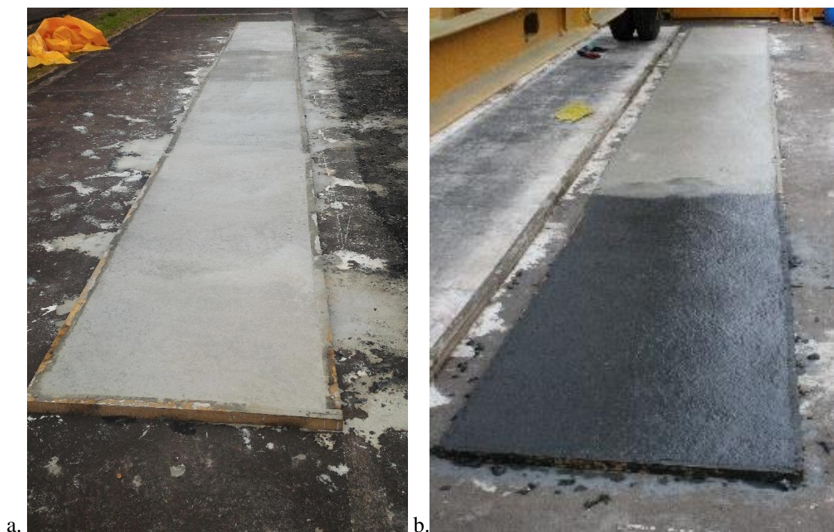
Figura 5.44: Aparência dos recapeamentos recém terminados de concretar: (a) recapeamento de 50 mm, (b) recapeamento de 30 mm. Fonte: fotos do autor.
