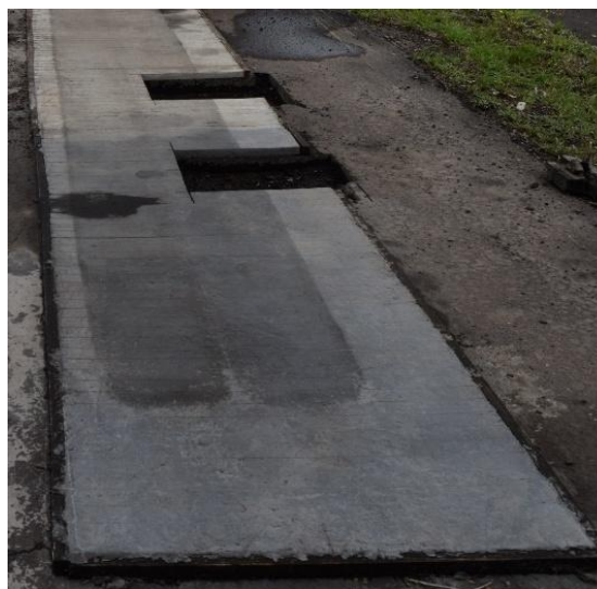
Figura 5.51: Extração de seções no recapeamento de 30 mm. Fonte: foto do autor.
