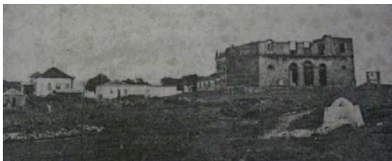
Figura 660: Caçapava. Praça com a igreja em construção e poço d'água, em 1899. Fonte: Acervo Museu Municipal.
