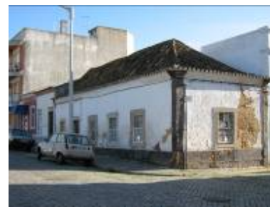
Figura 148: Faro, casa térrea na Mouraria. Fonte: fotografia da autora, 18/02/2007
