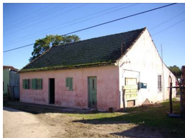
Figura 639: Casa sobre a praça. Telhado a duas águas e meia água posterior. Fonte: fotografia da autora, 08/07/2008
