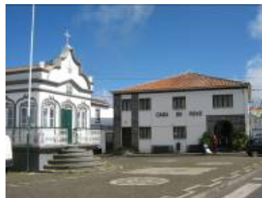
Figura 345: Capela da freguesia de Vila Nova Fonte: fotografia da autora, 03/03/2008.
