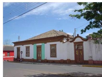
Figura 616: Cidade Baixa, casa residencial Fonte: fotografia da autora, 13/03/2006.
