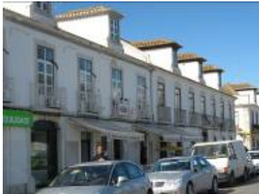
Figura 456: Edifícios das Sociedades, rua da orla Fonte: fotografia da autora, 17/02/2007
