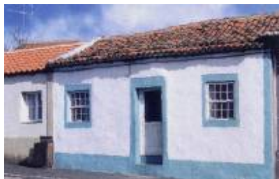
Figura 329: Casa térrea na Vila do Porto, Santa Maria. Fonte: Inventário do Patrimônio Imóvel do Concelho da Vila do Porto, 2006, p. 185.
