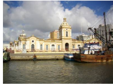
Figura 501: Cais e Alfândega Fonte: fotografia da autora, 23/07/2008
