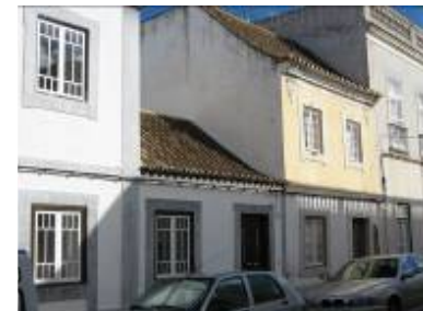
Figura 461: Casas modificadas Fonte: fotografia da autora, 17/02/2007
