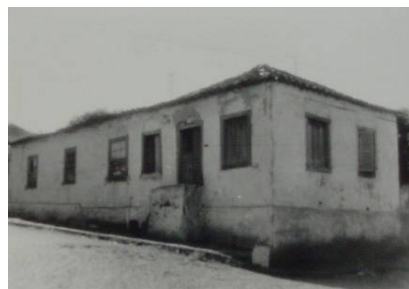
Figura 579: Cachoeira, casa de esquina Fonte: Acervo IPHAN, s/d.
