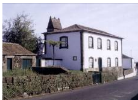
Figura 291: Casa rural na freguesia de Ramo Grande. Concelho de Praia, Terceira Fonte: IAC [2004]
