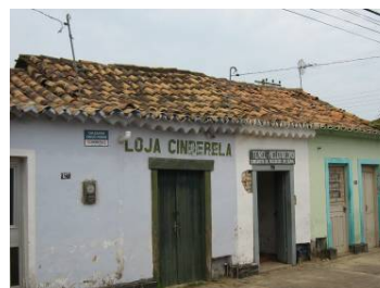
Figura 507: Mostardas, casas sobre a rua principal. Fonte: fotografia da autora, 10-10-2007
