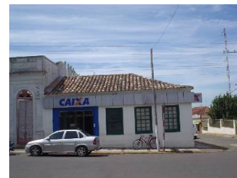
Figura 613: Taquari. Lado leste da praça, Fonte: fotografia da autora, 13/03/2006.
