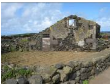
Figura 233: Casa em ruínas, Caldeira, Concelho de Praia, norte da ilha Terceira. Fonte: fotografia da autora, 02/03/2008
