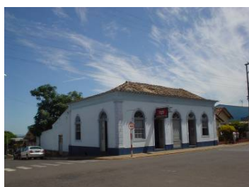
Figura 629: Casa Rua Oswaldo Aranha 1872 Fonte: fotografia da autora, 13/03/2006.
