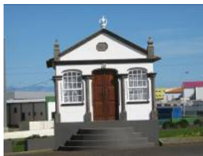
Figura 338: Capela do Cabo da Praia. Concelho de Praia, Ilha Terceira Fonte: fotografia da autora, 02/03/2008.
