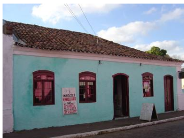
Figura 569: Casas de media morada e de porta e janela, na rua da Igreja Fonte: fotografia da autora,
