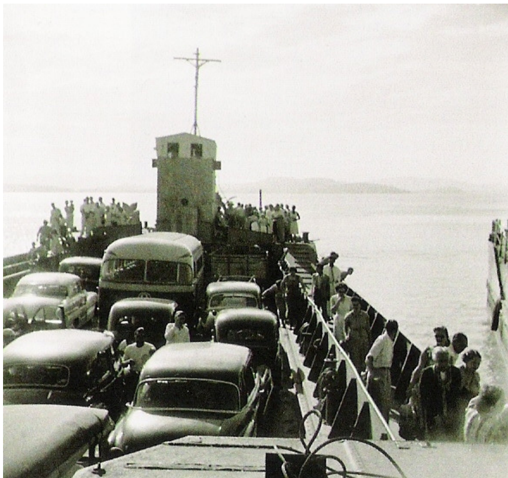
Figura 5. Travessia de balsa – Atracadouro de balsas da Vila Assunção, início dos anos 50.
