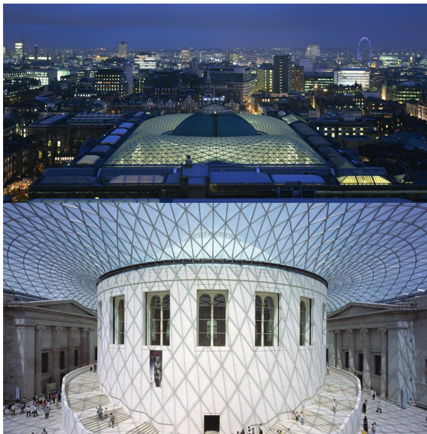
Figura 8 - Cobertura do pátio central do Museu Britânico
