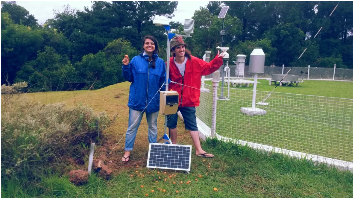
Figura 78. Exemplo de instalação de EMM concluída ao final de Mutirão das EMM. Fonte: Leonardo Sehn (2018).
