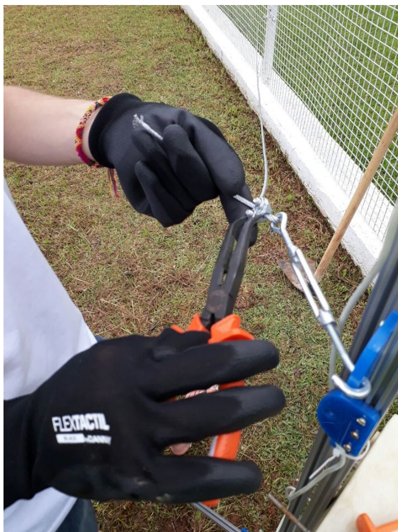
Figura 77. Fixação de grampo de cabo de aço sendo feita durante Mutirão das EMM. Fonte: Leonardo Sehn (2018).
