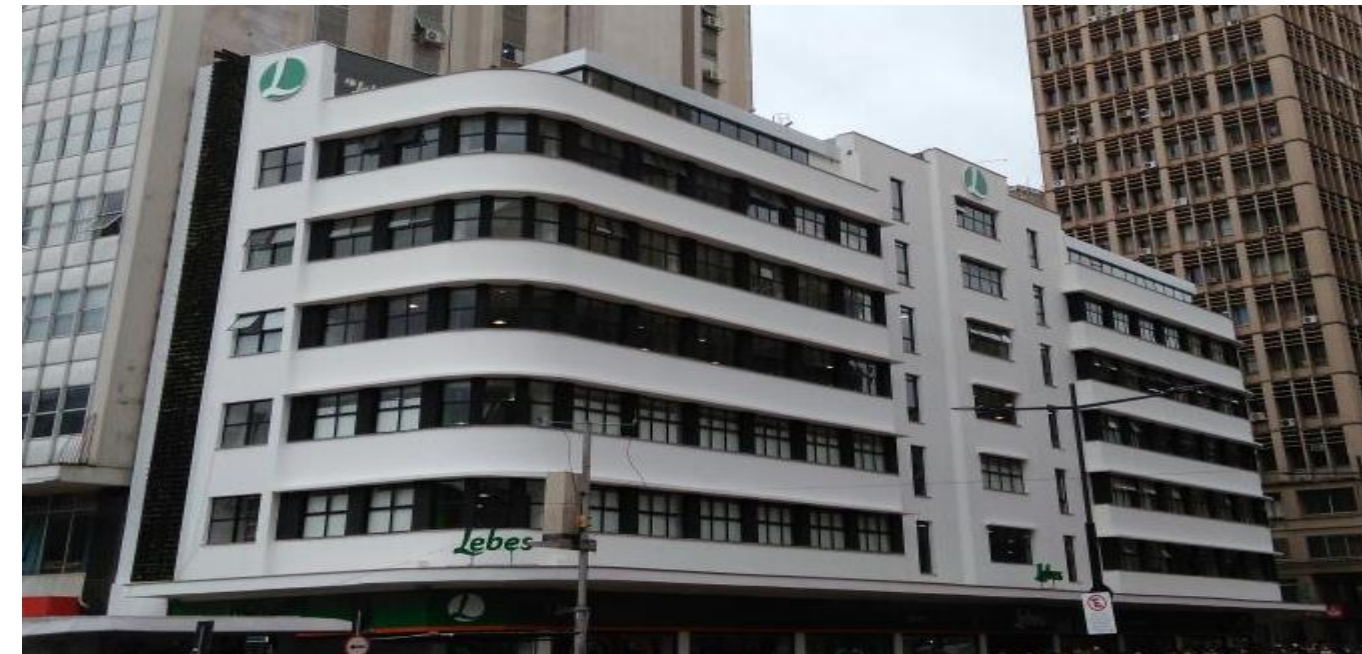
Figura 1 – Fachada revitalizada com incorporação de TiO_2 na argamassa de reboco do Edifício Guaspári – POA/RS
