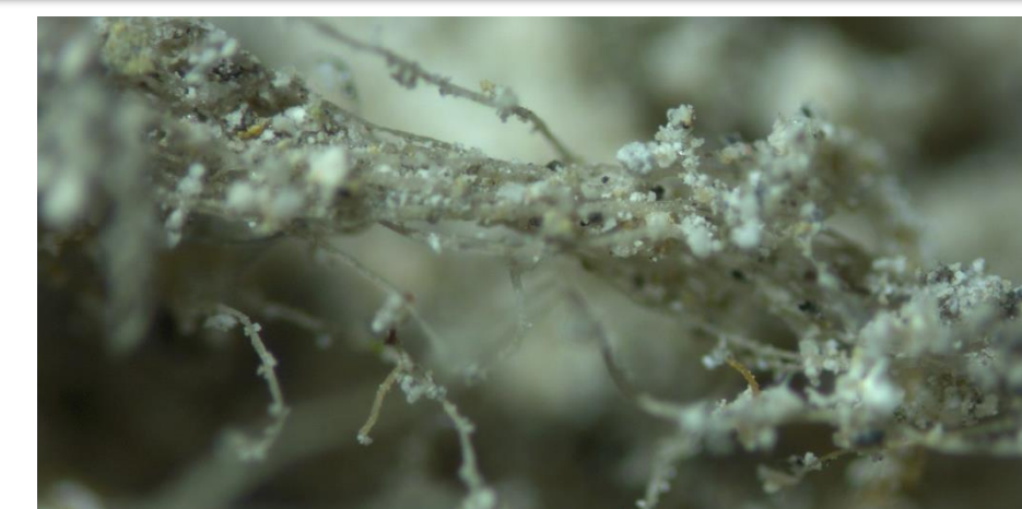
Figura 1 – Filamentos de fungos em argamassa
