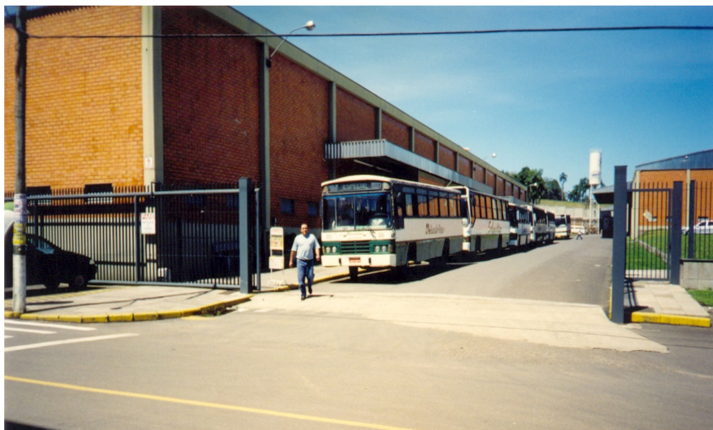
Figura 6: Visão parcial dos pavilhões que compõem a fábrica
