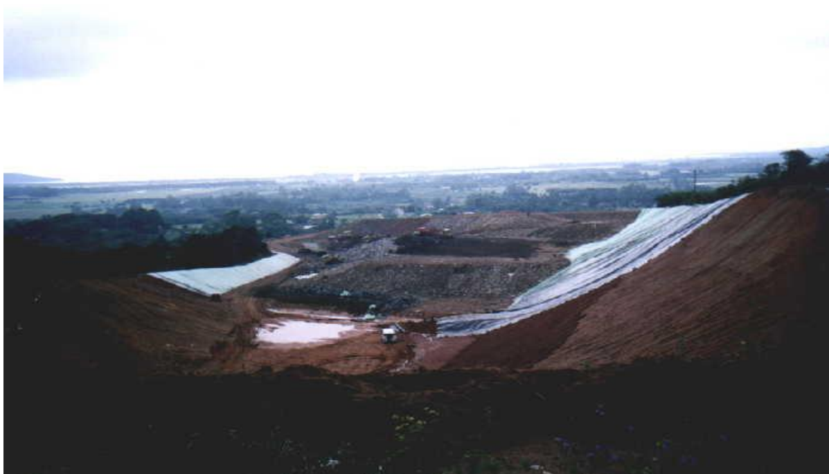
Foto 6: Aterro sanitário da extrema
