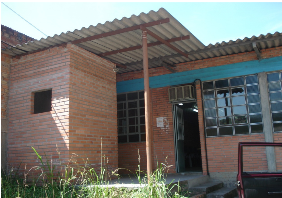
Fig. 13 – Prédio do Telecentro.
