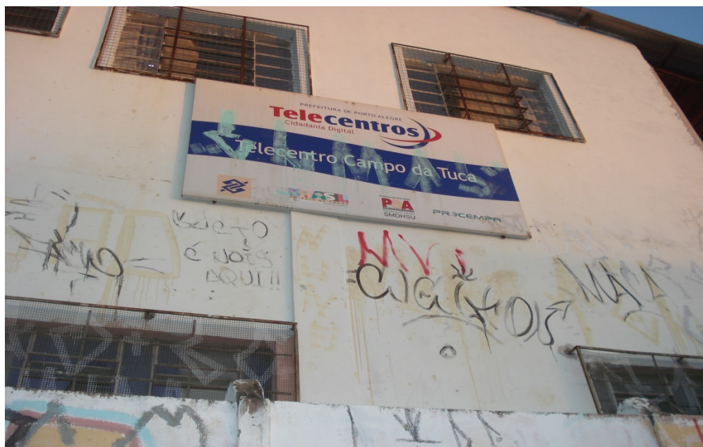
Fig. 5 – Prédio do Telecentro.
